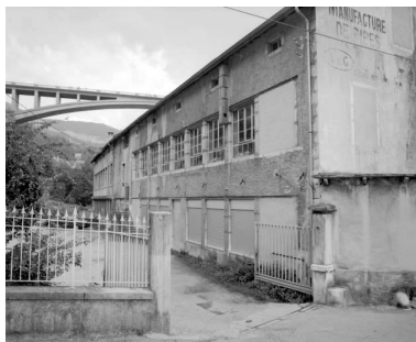
Façade sur cour des ateliers de fabrication. Phot. Jérôme Mongreville IVR43_19923900611X
