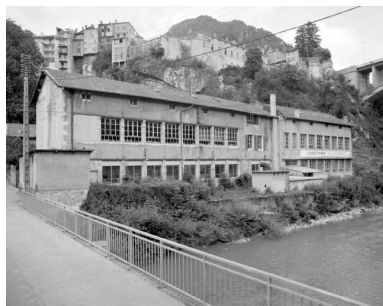
Façade sur Bienne des ateliers de fabrication. Phot. Jérôme Mongreville IVR43_19923900610X
