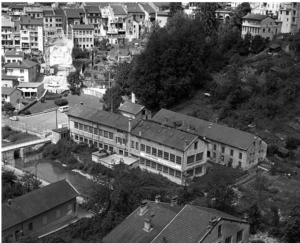
Vue d'ensemble plongeante depuis le sud-est.
