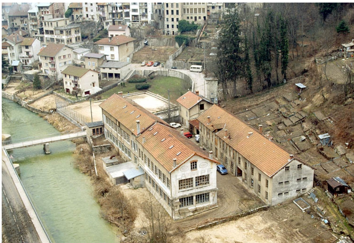
Vue d'ensemble plongeante depuis le sud-est.
