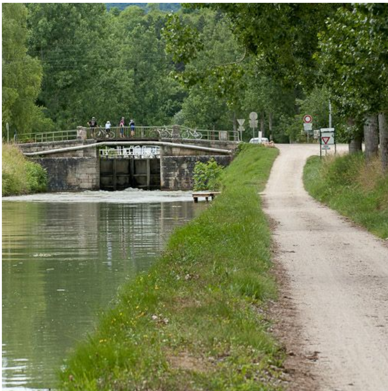
Vue du pont sur écluse.
