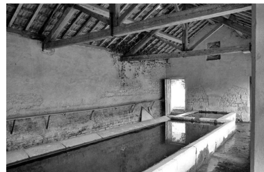
Vue intérieure du lavoir. Phot. Bernard Lardière IVR43_19817000524Z
