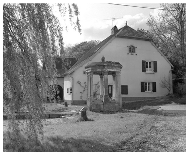
Détail de la fontaine. Phot. Yves Sancey IVR43_19857000016X
