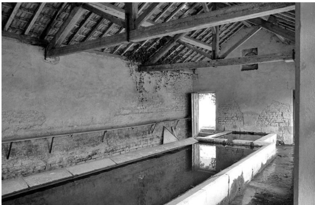
Vue intérieure du lavoir.
