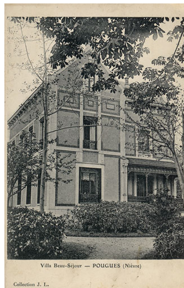
Vue ancienne. Autr. auteur inconnu IVR26_20205800364NUC4A
