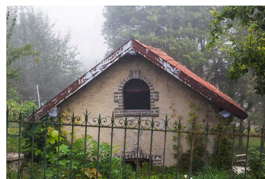
Bûcher : pignon sud. Phot. Yves Sancey IVR43_20132502140NUC2A
