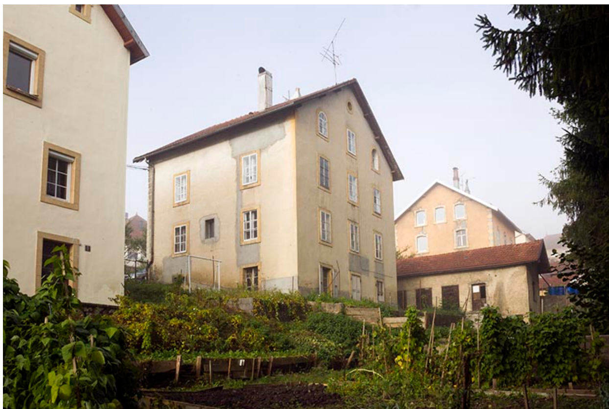
Façades postérieure et latérale droite.
