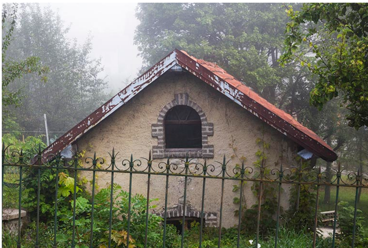
Bûcher : pignon sud.
