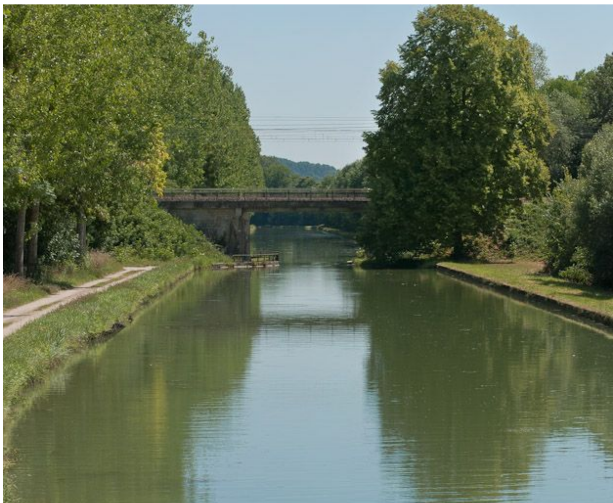
Vue du pont.
