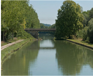
Vue du pont.
