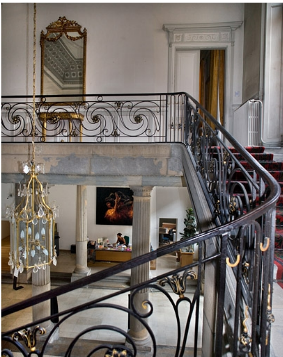
Détail de la ferronnerie de l'escalier.
