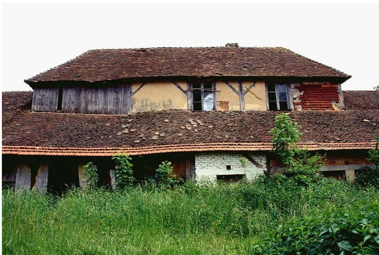
Façade ouest du logement d'ouvriers.
