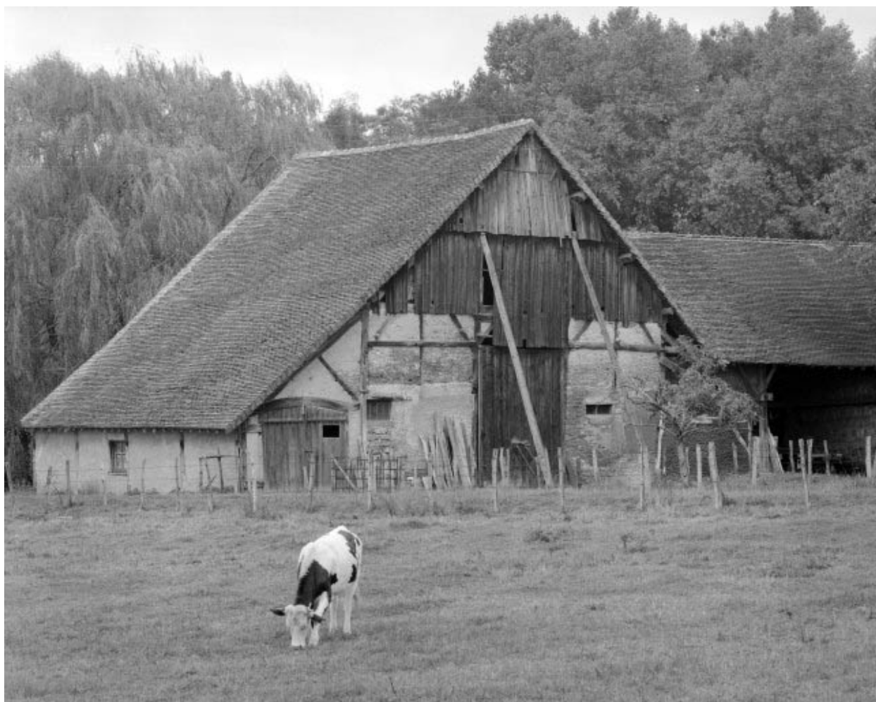
Remise, écurie et fenil depuis le sud-est.
