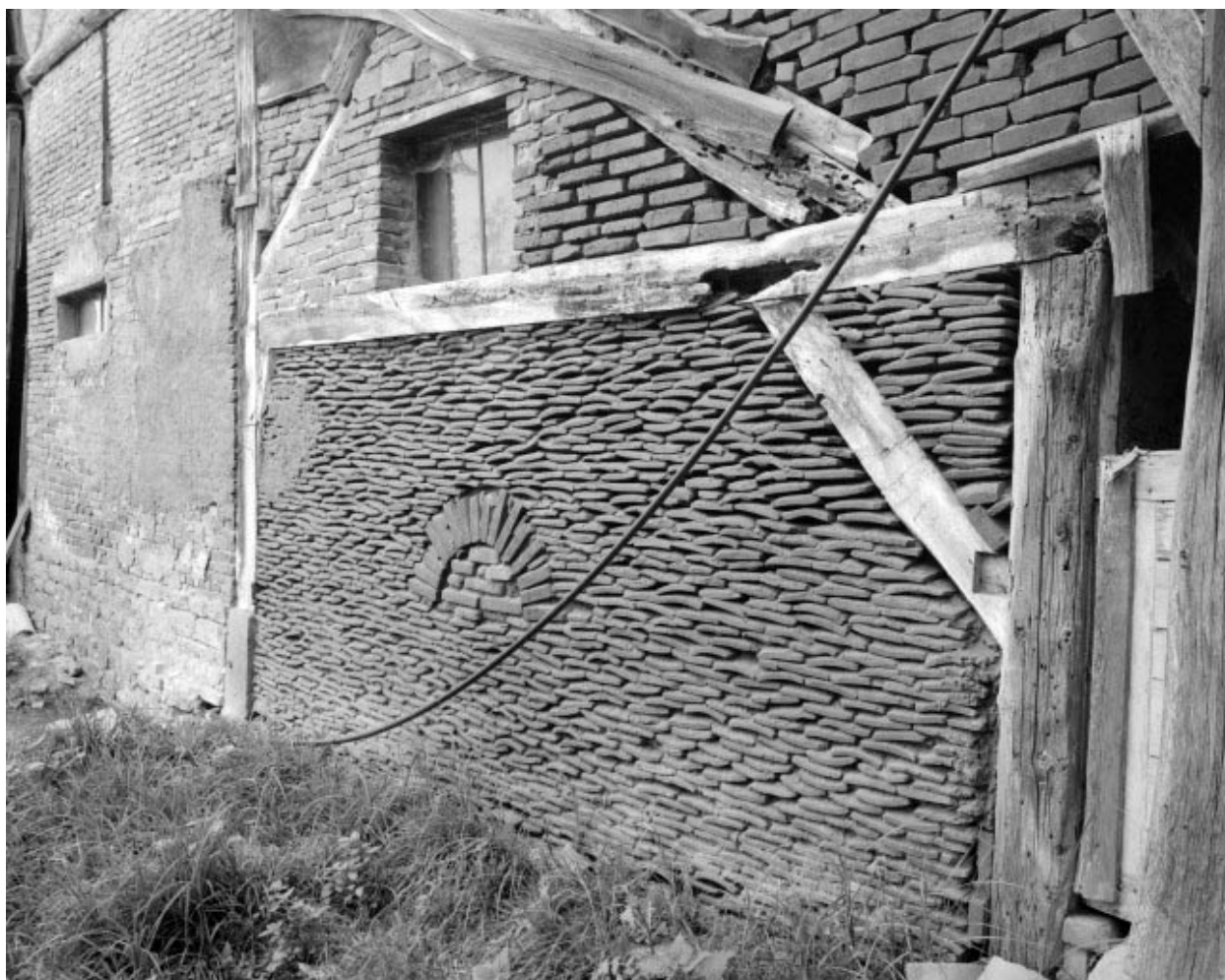
Façade ouest de l'écurie. Détail du pan-de-bois hourdé de tuiles et briques.
