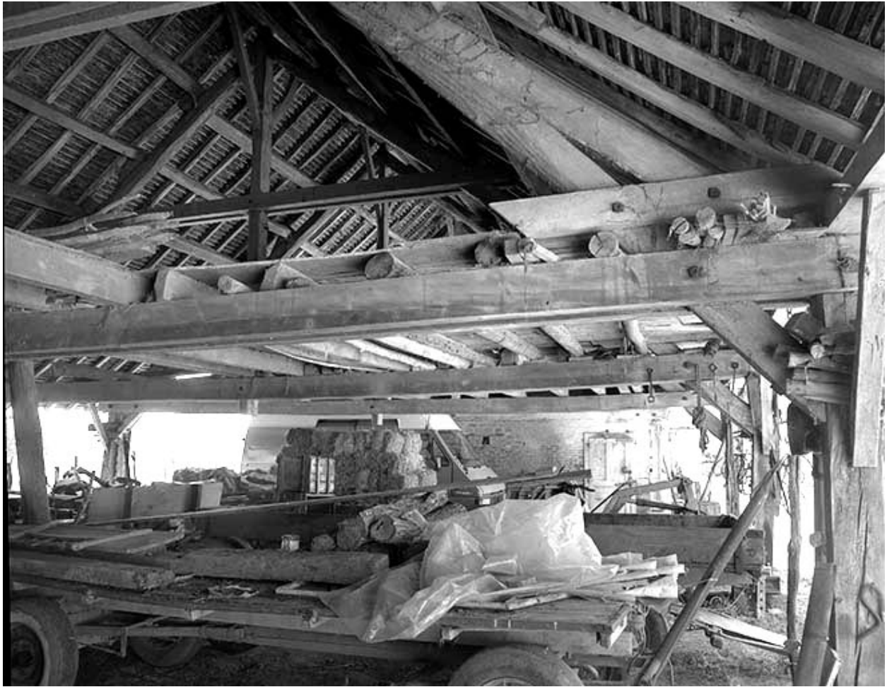
Vue intérieure de la pièce de séchage.
