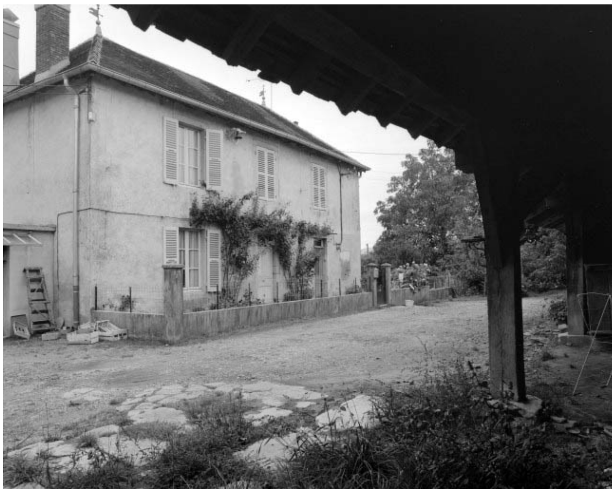
Logement patronal de trois quarts gauche.
