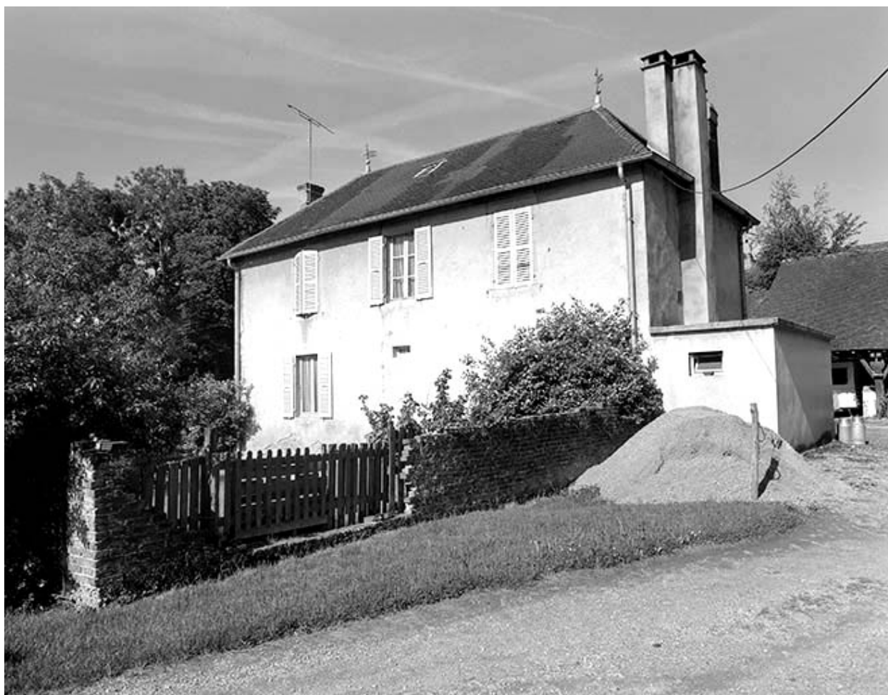
Façade postérieure du logement patronal.
