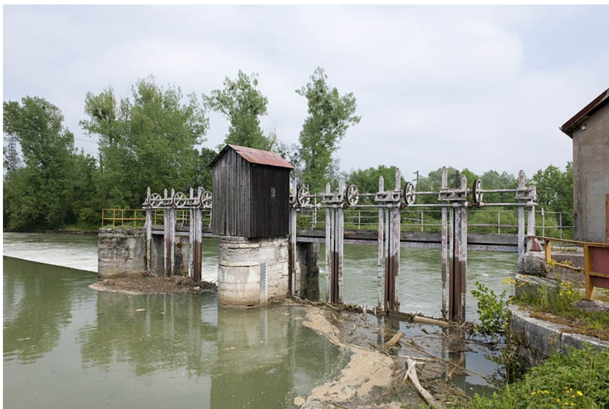
Vannage du barrage.
