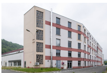
Bâtiment administratif. Façade nord-ouest. Phot. Jérôme Mongreville IVR43_20122501086NUC4A
