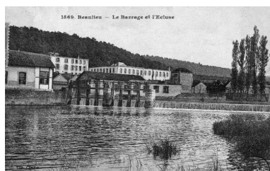
Beaulieu. Le barrage et l'écluse. Carte postale, s.n., s.d. [début du 20e siècle]. Phot. Raphaël Favereaux, Autr. IVR43_20122501528NUC2
