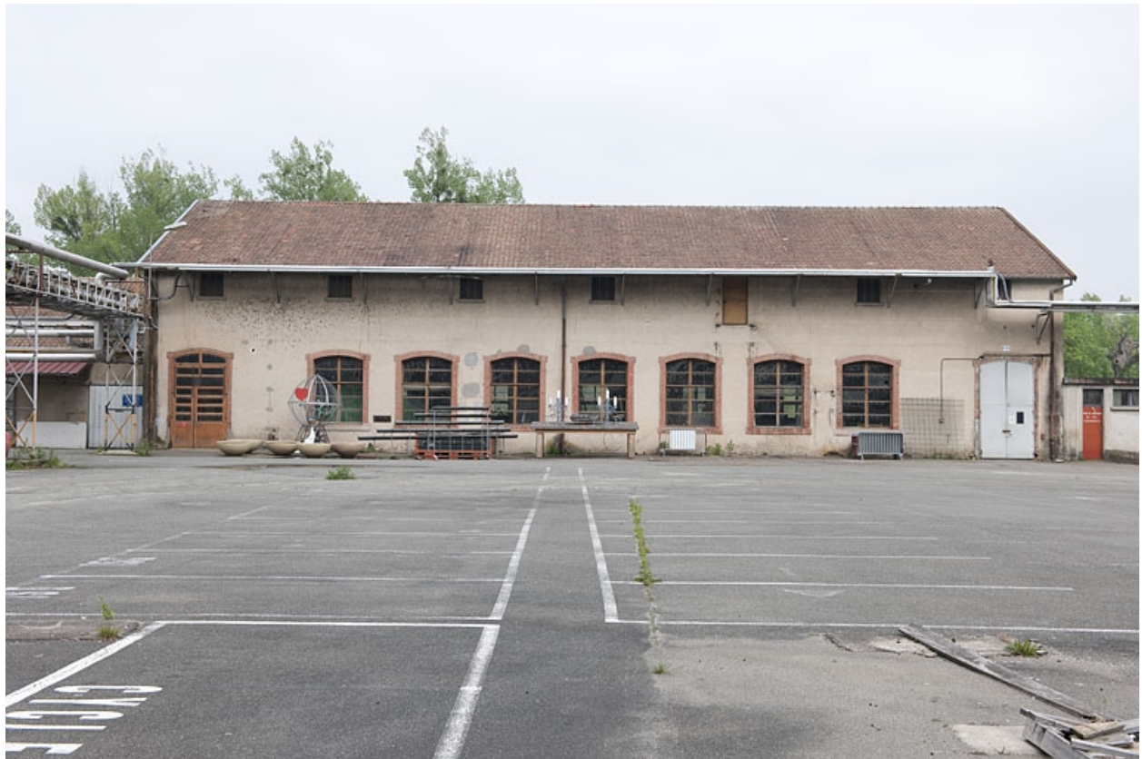
Bâtiment industriel. Vue de face.
