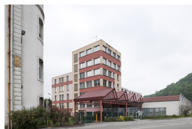
Bâtiments situés au nord de l'entrée. Phot. Jérôme Mongreville IVR43_20122501090NUC4A
