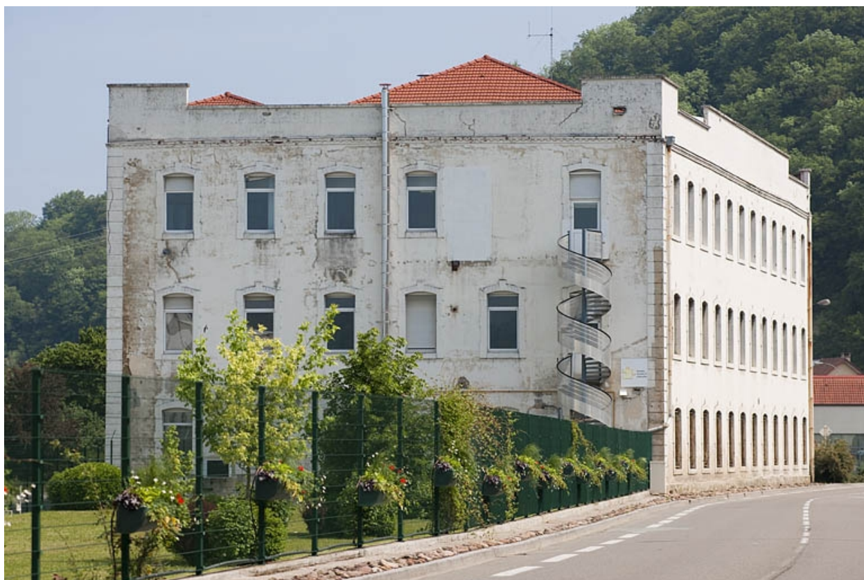
Immeuble de bureaux. Vue depuis le sud.
