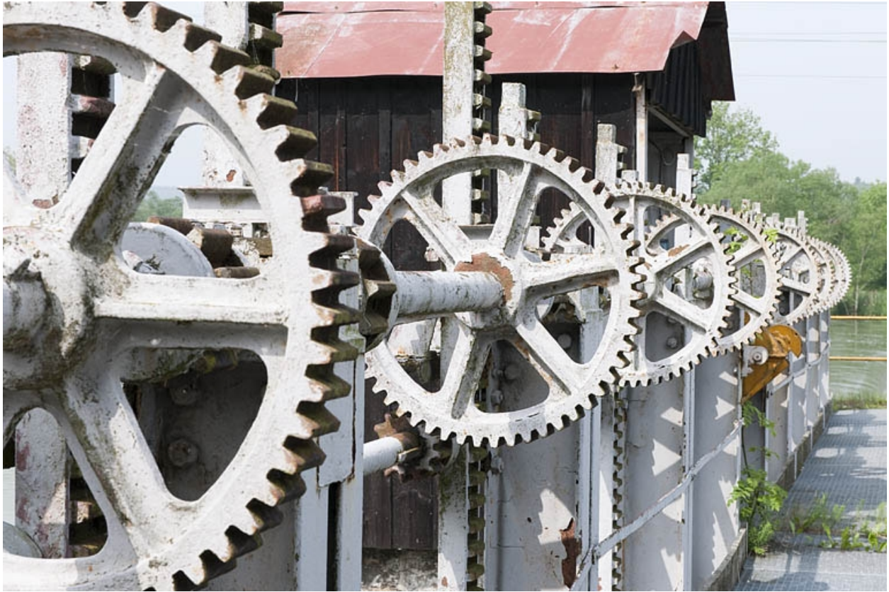
Vannage du barrage. Détail des engrenages.
