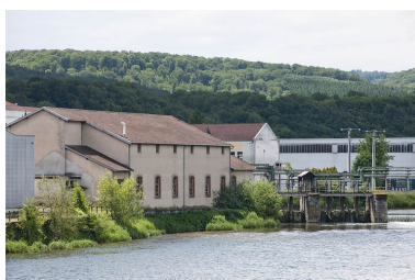
Vue d'ensemble depuis le pont en aval. Phot. Jérôme Mongreville IVR43_20122501101NUC4A
