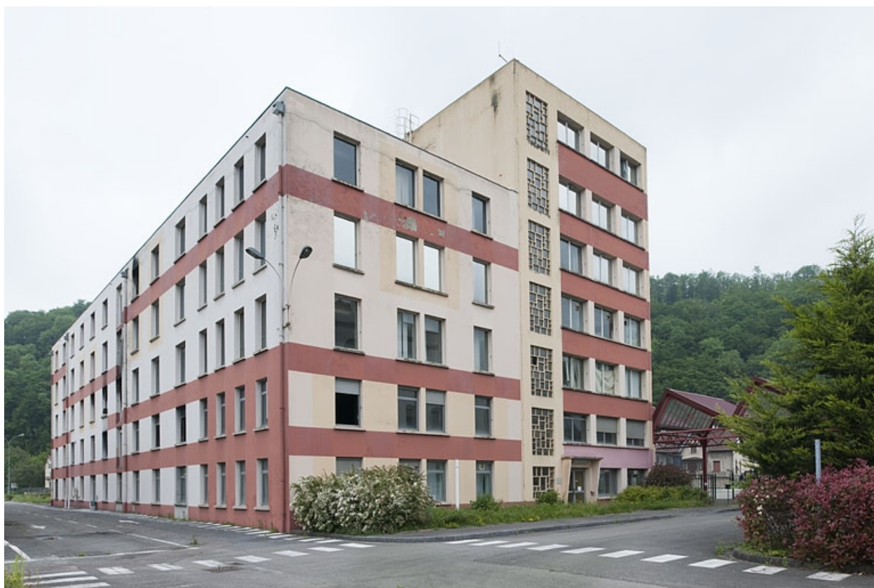
Bâtiment administratif. Vue depuis l'ouest.
