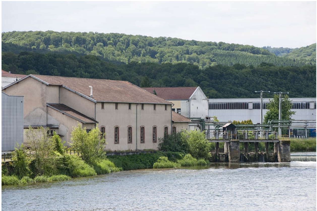
Vue d'ensemble depuis le pont en aval.
