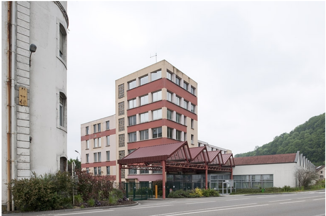
Bâtiments situés au nord de l'entrée.
