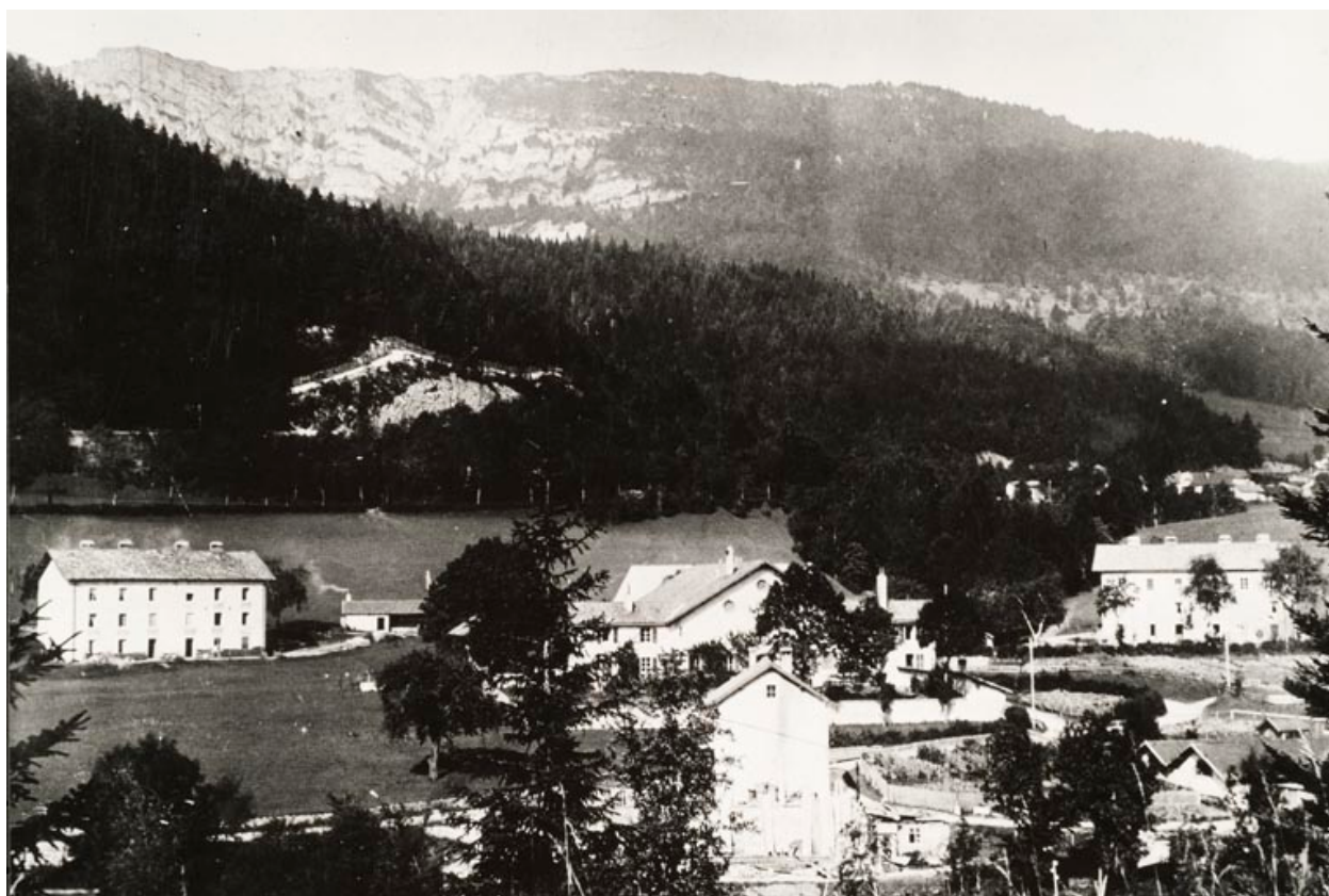
Vue générale après l'incendie de 1913.
