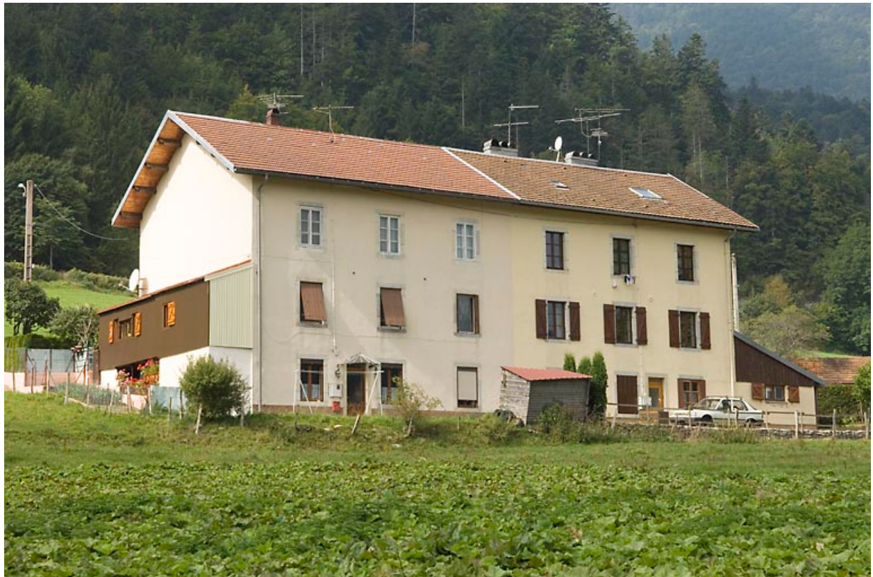
Immeuble à logements, façade postérieure.
