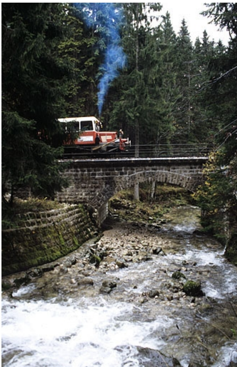
Elévation nord (amont), avec draisine.
