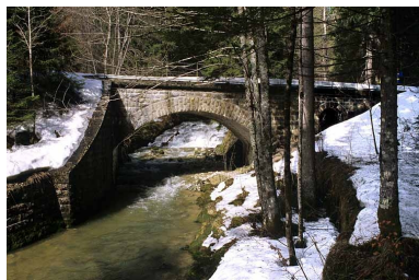
Elévation sud (aval). Phot. Yves Sancey IVR43_20053900382ZA
