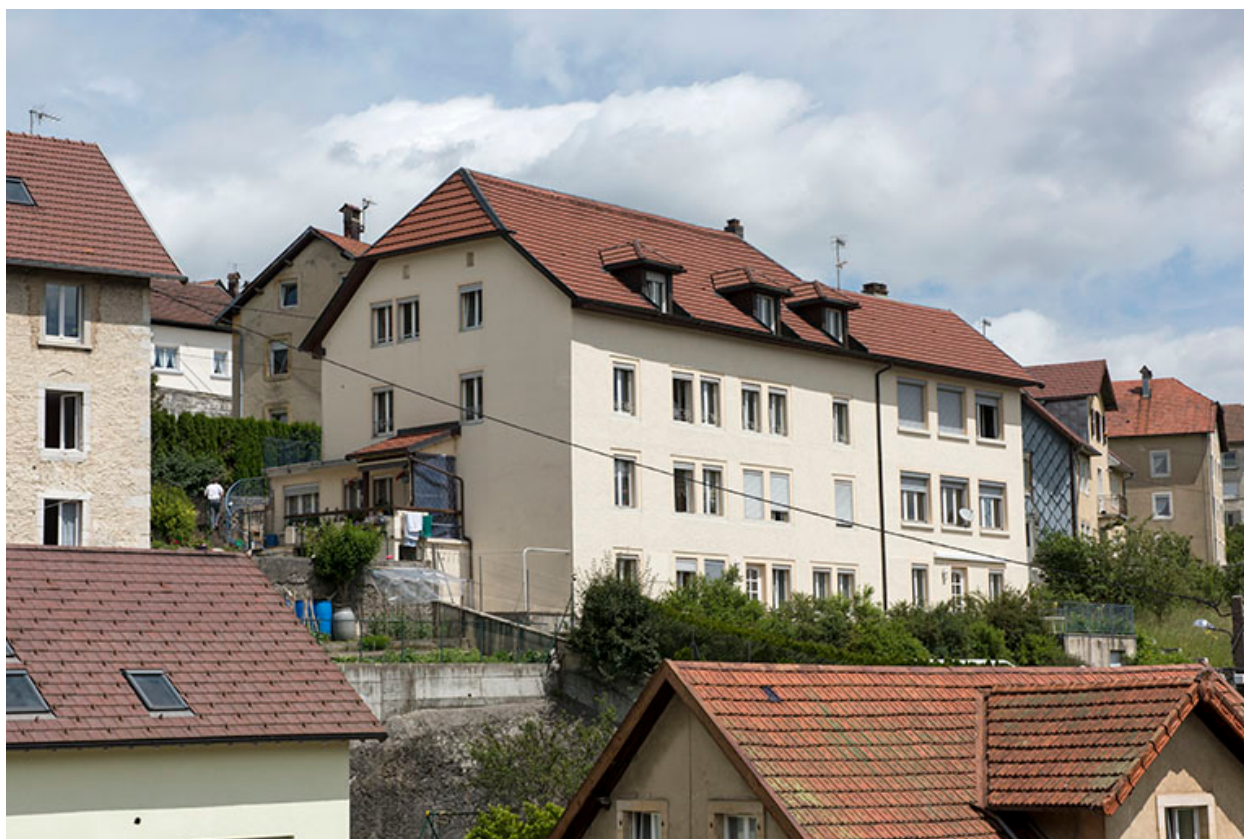
Façades postérieure et latérale gauche.
