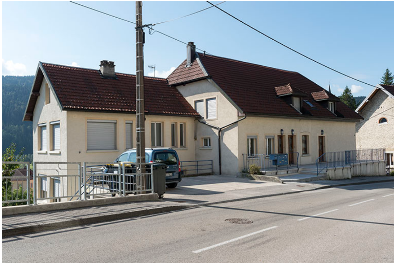
Façades antérieure et latérale gauche.
