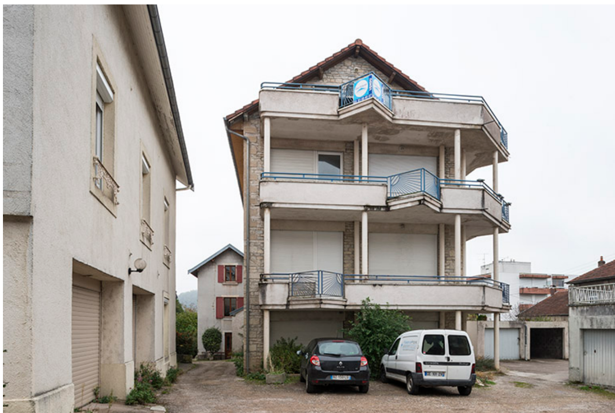
Mur-pignon nord de l'atelier.
