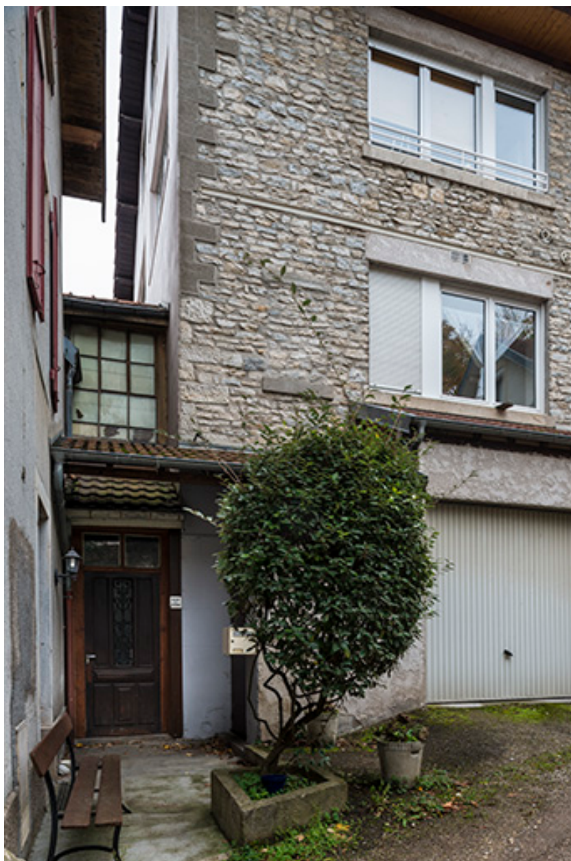
Extrémité sud de l'atelier de fabrication.
