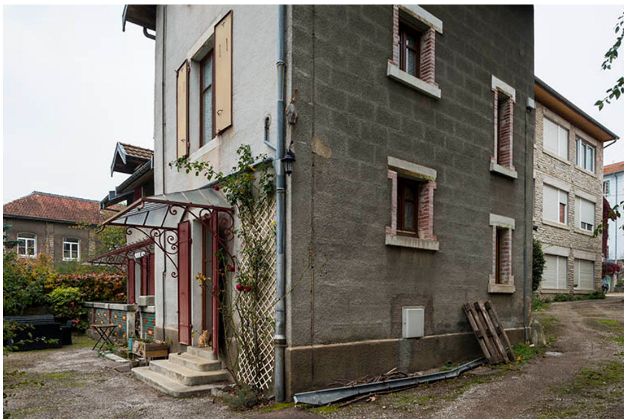
Logement, adossé au pignon sud de l'atelier.
