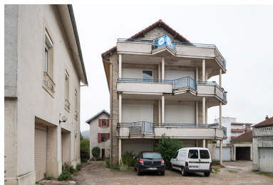
Mur-pignon nord de l'atelier.
