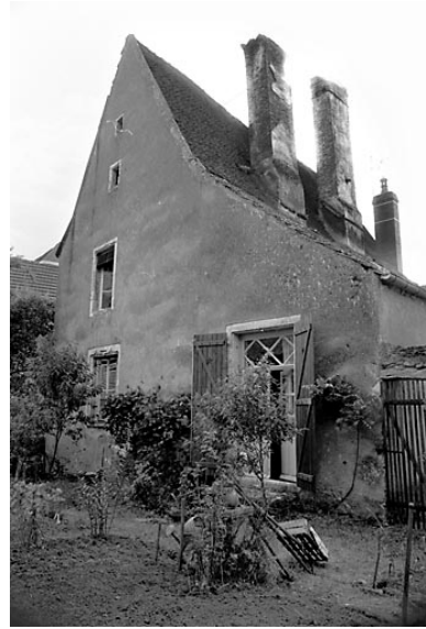
Façade postérieure. Phot. Bernard Lardière IVR43_19817000826Z
