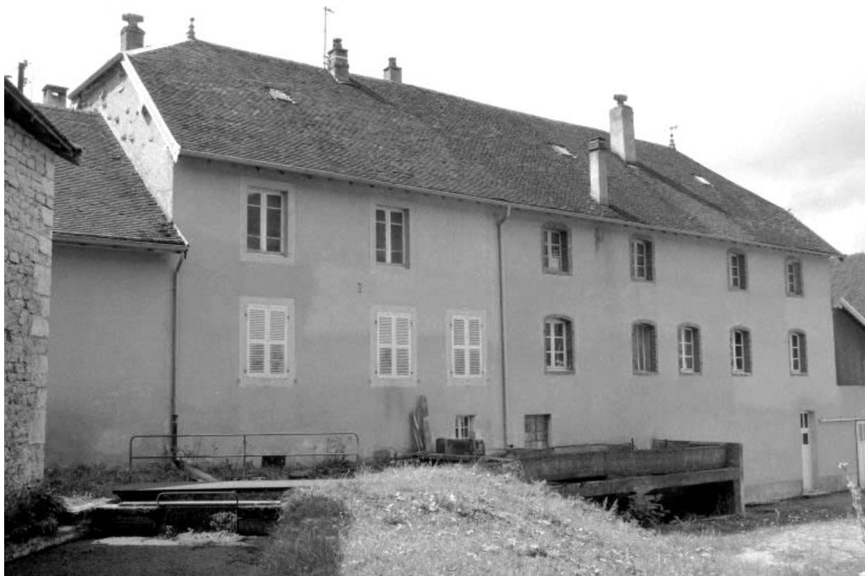
Façade postérieure du premier atelier de fabrication.
