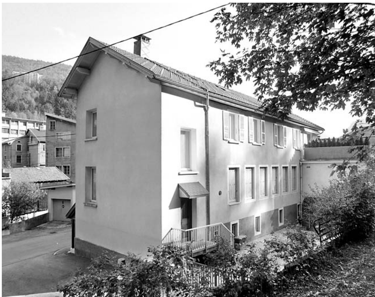
Elévation postérieure, de trois quarts gauche.
