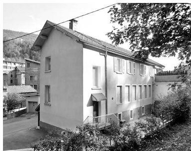
Elévation postérieure, de trois quarts gauche. Phot. Yves Sancey IVR43_20033900271X
