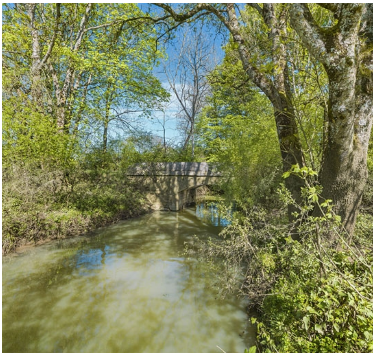
Vue d'ensemble du pont.
