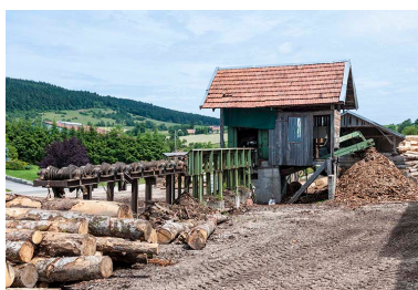
Poste d'écorçage. Phot. Jérôme Mongreville IVR43_20152501473NUC4A
