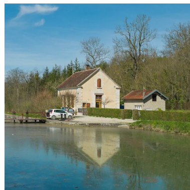
Maison éclusière avec son annexe. Phot. Pierre-Marie Barbe-Richaud IVR26_20138900066NUC4AQ
