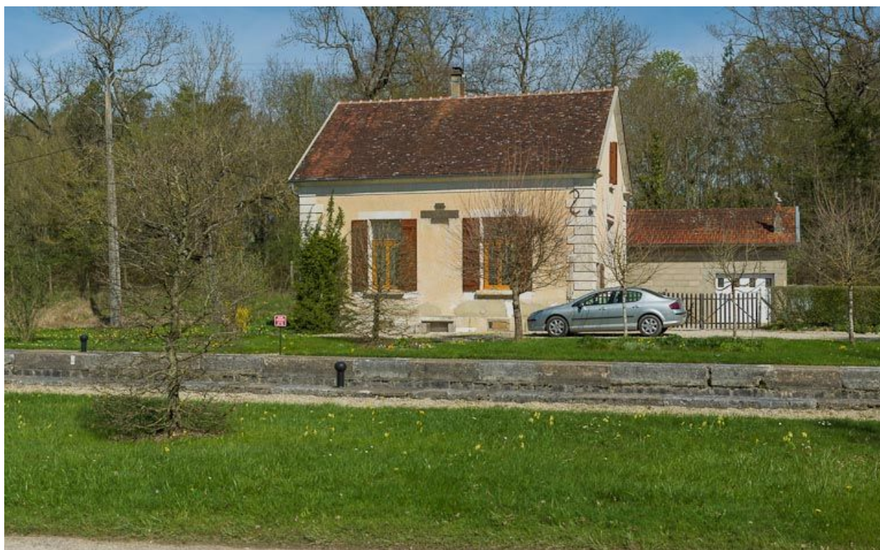
Vue de face de la maison éclusière.
