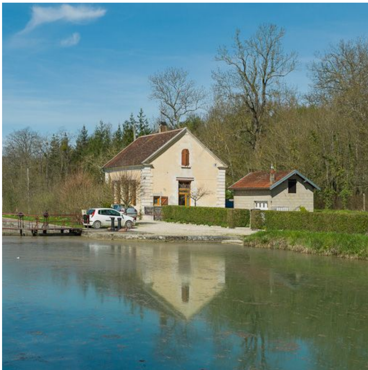
Maison éclusière avec son annexe.
