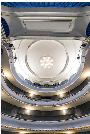
Balcons et plafond, vus du parterre. Phot. Pierre-Marie Barbe-Richaud IVR26_20222100027NUC4A
