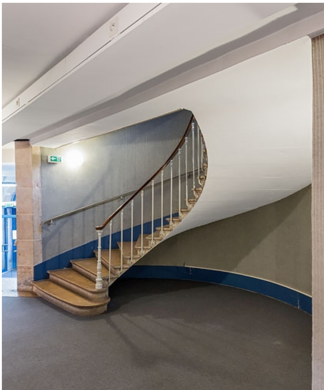
Escalier côté jardin : départ au rez-de-chaussée.
