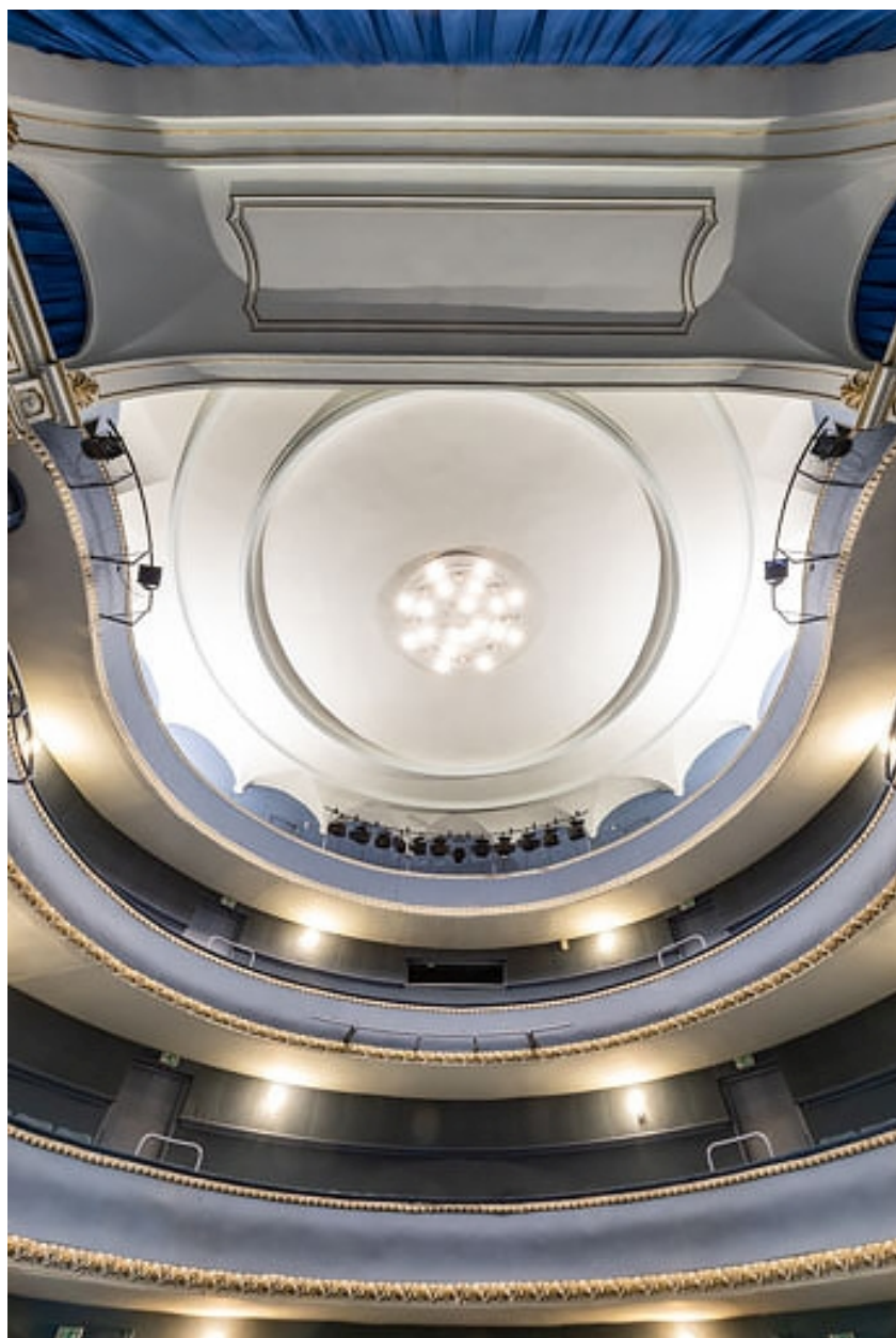
Balcons et plafond, vus du parterre.
