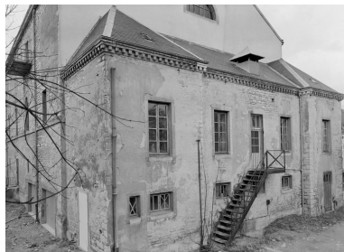
Elévation postérieure, en 1988. Phot. Jean-Luc Duthu IVR26_19882101019V
