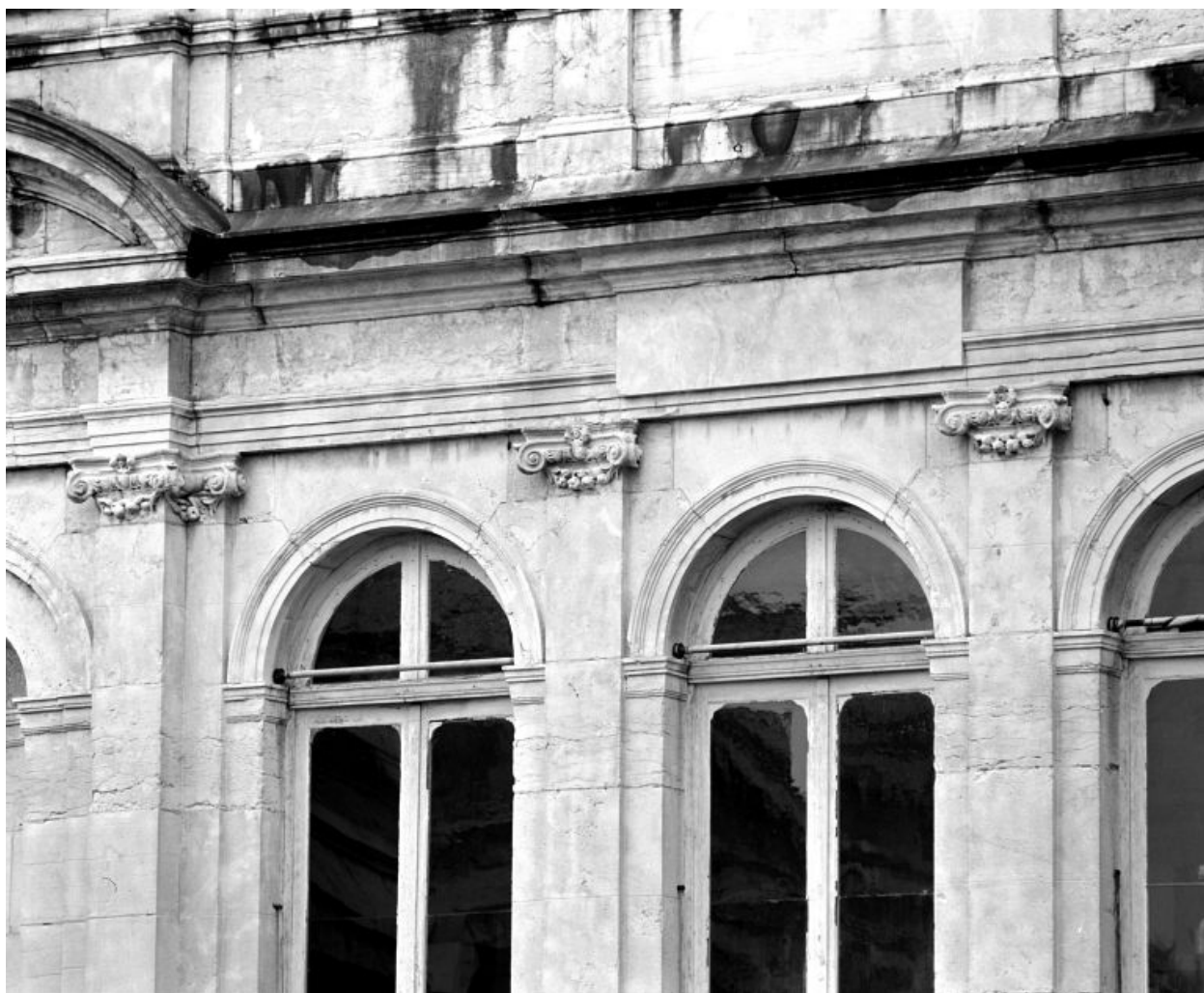
Façade : détail de l'entablement, en 1988.
