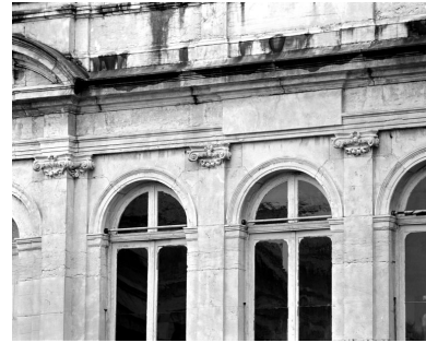
Façade : détail de l'entablement, en 1988. Phot. Michel Rosso IVR26_19882101018X
