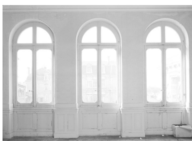
Foyer du public, en 1988 : détail des fenêtres. Phot. Jean-Luc Duthu IVR26_19882100582V
