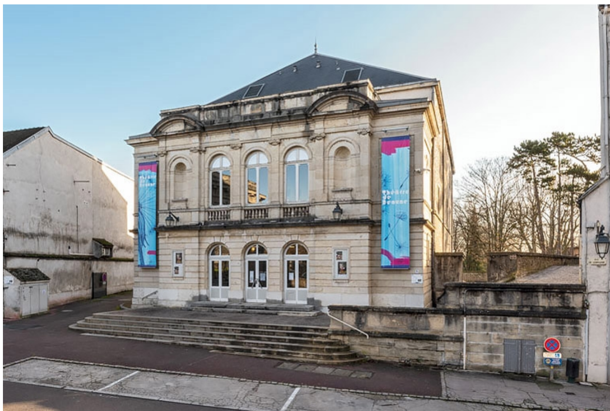
Vue d'ensemble sur la rue de Lorraine.
