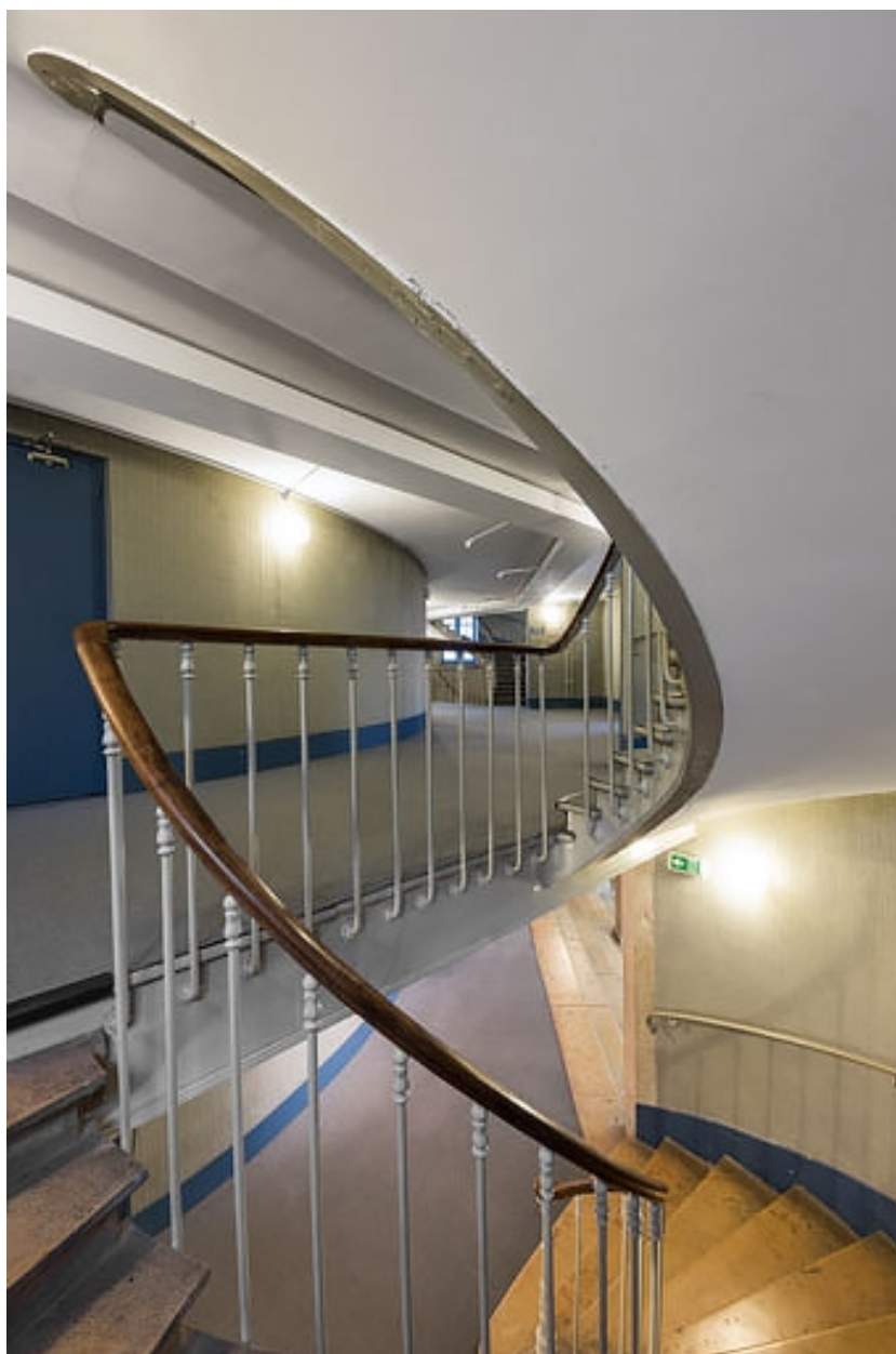
Escalier côté jardin : palier du 1er.
