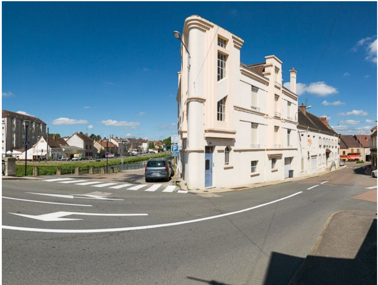
Vue de l'immeuble de style paquebot.
