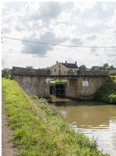
Vue d'ensemble du pont.
