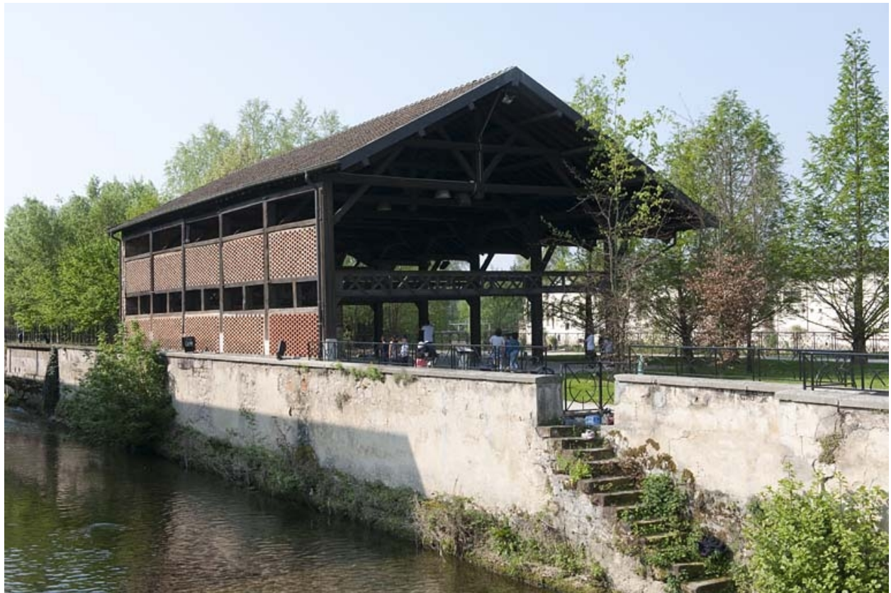
Hangar à bois.
