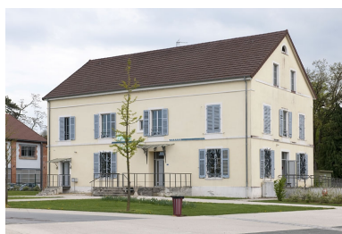
Bureaux. Phot. Jérôme Mongreville IVR43_20112501134NUC4A
