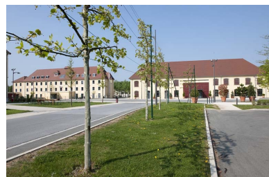
Ateliers de filature depuis l'entrée. Phot. Jérôme Mongreville IVR43_20112501139NUC4A
