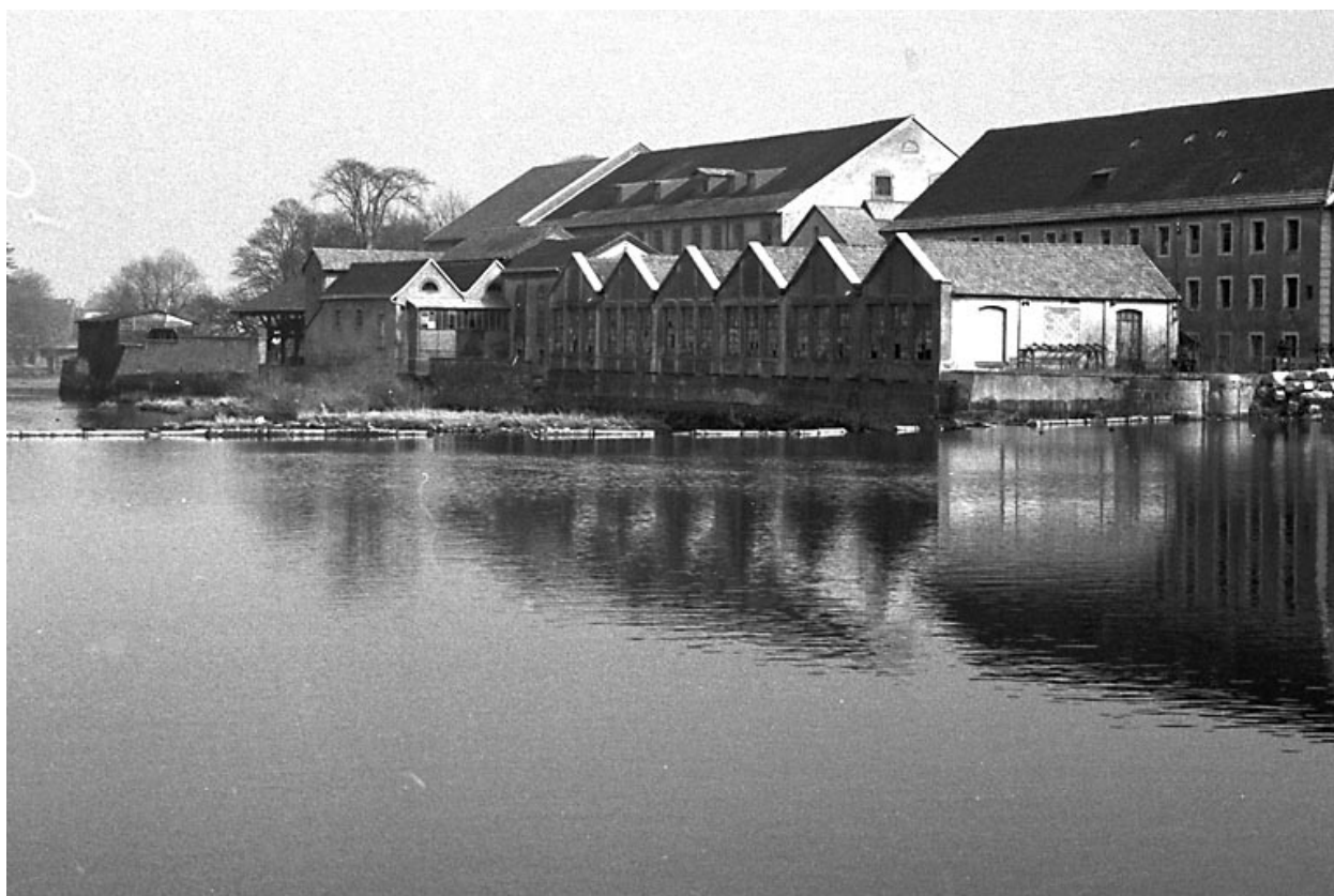
Vue d'ensemble depuis l'amont en 1983.
