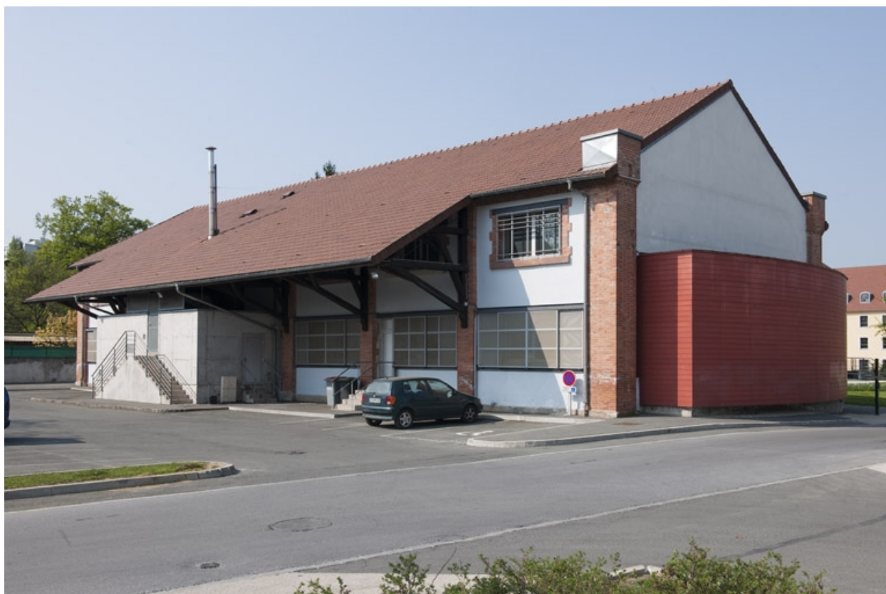
Entrepôt industriel à l'entrée du site.
