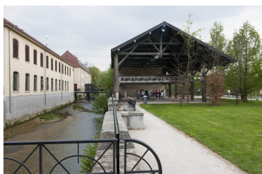
Ateliers de filature et hangar à bois. Phot. Jérôme Mongreville IVR43_20112501132NUC4A
