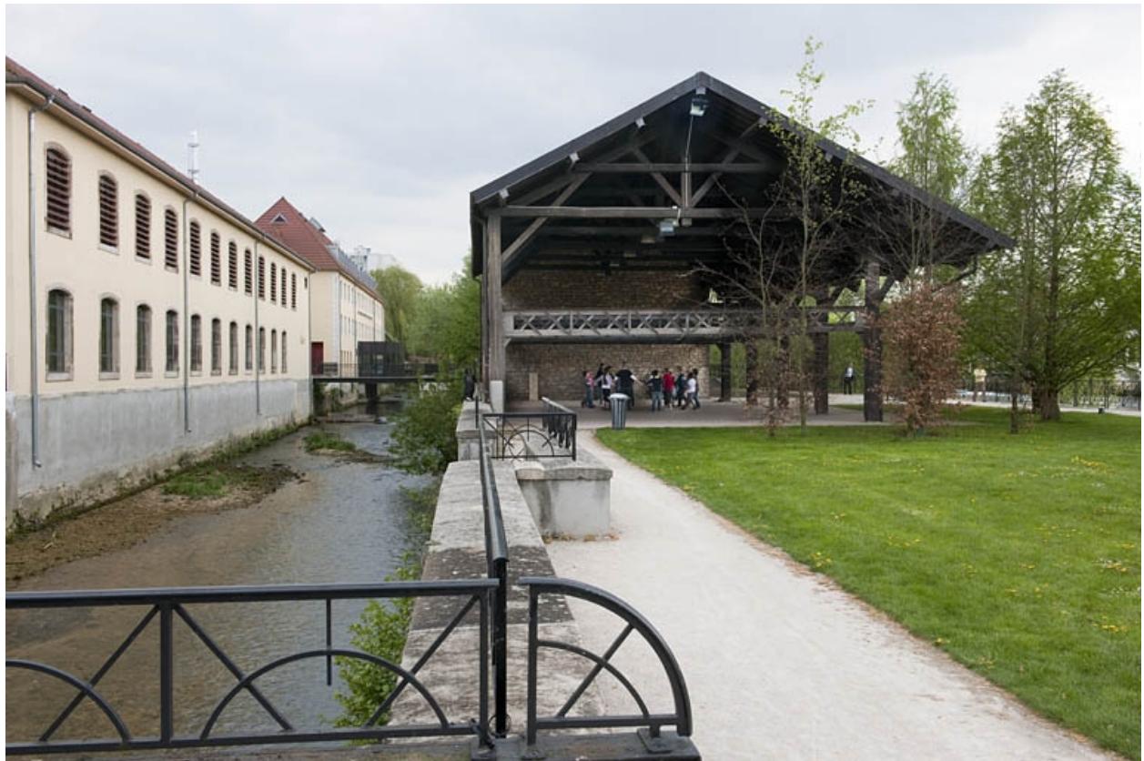
Ateliers de filature et hangar à bois.
