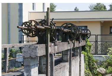
Système de vannage du bief de dérivation. Mécanisme de contrôle. Phot. Jérôme Mongreville IVR43_20112501142NUC4A
