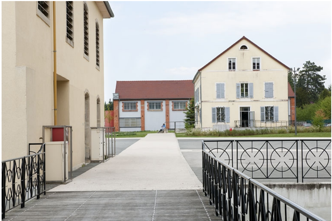
Bureaux et entrepôt industriel depuis l'ouest.
