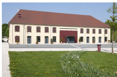
Atelier de filature nord. Phot. Jérôme Mongreville IVR43_20112501137NUC4A
