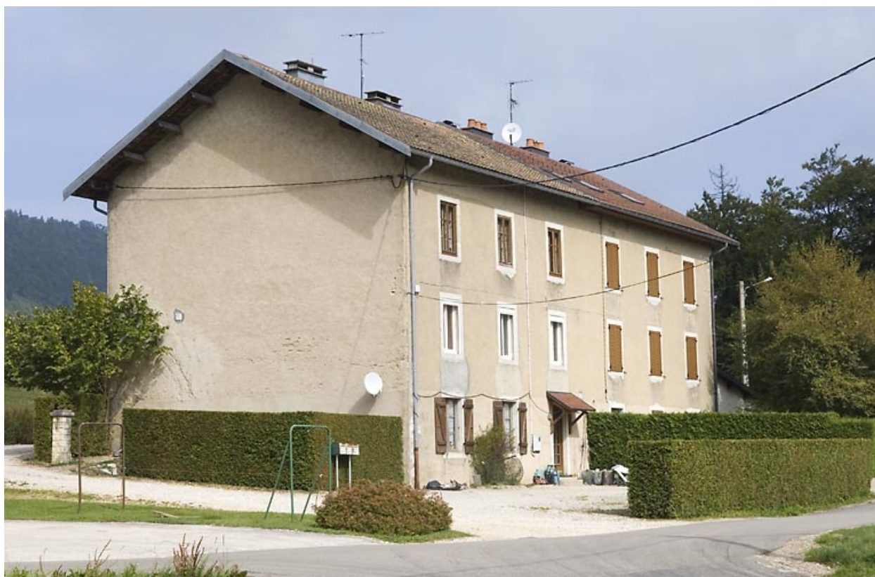
Immeuble de logements, au nord-ouest.
