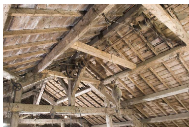
Grange haute : poulies et contrepoids de la déchargeuse dans la charpente. Phot. Jérôme Mongreville IVR43_20082501113NUC2A
