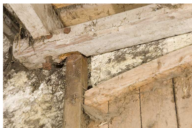
Grange haute : fixation du pivotement haut d'un vantail de la porte. Phot. Jérôme Mongreville IVR43_20082501115NUC2A
