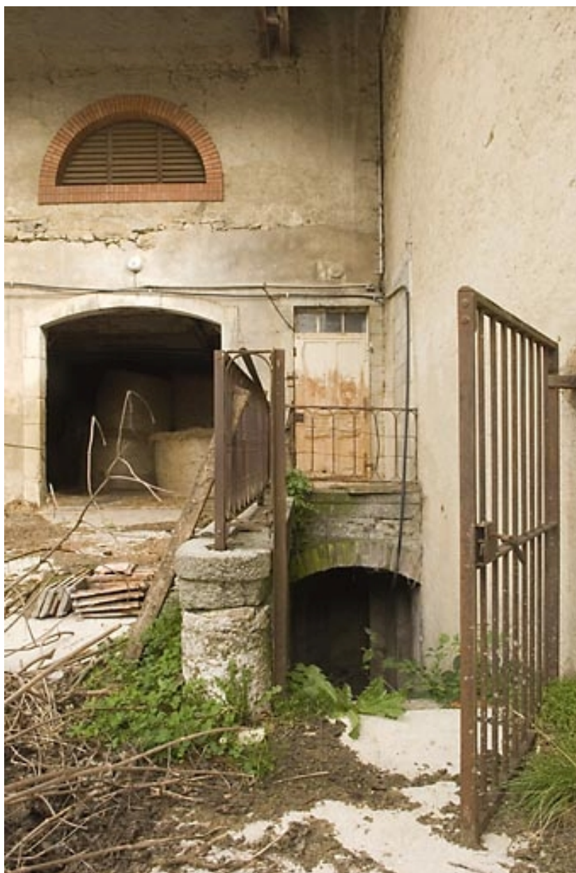
Habitation : façade postérieure, descente de cave.
