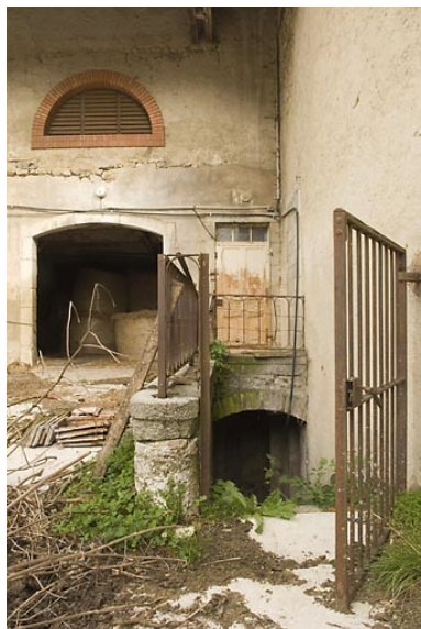
Habitation : façade postérieure, descente de cave. Phot. Jérôme Mongreville IVR43_20082501105NUC2A
