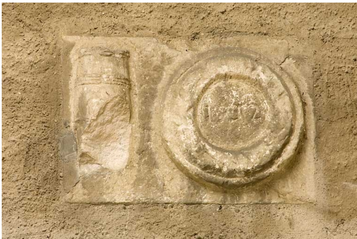
Habitation : façade antérieure, cartouche millésimé 1752.
