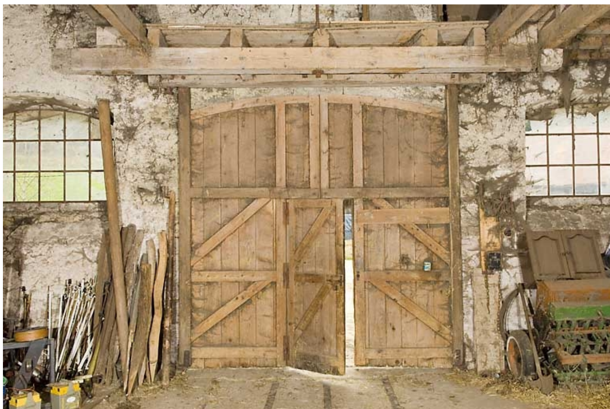
Grange haute : porte vue de l'intérieure.
