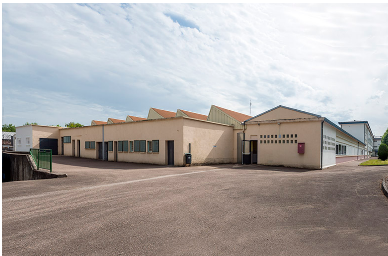
Ateliers : façade latérale.
