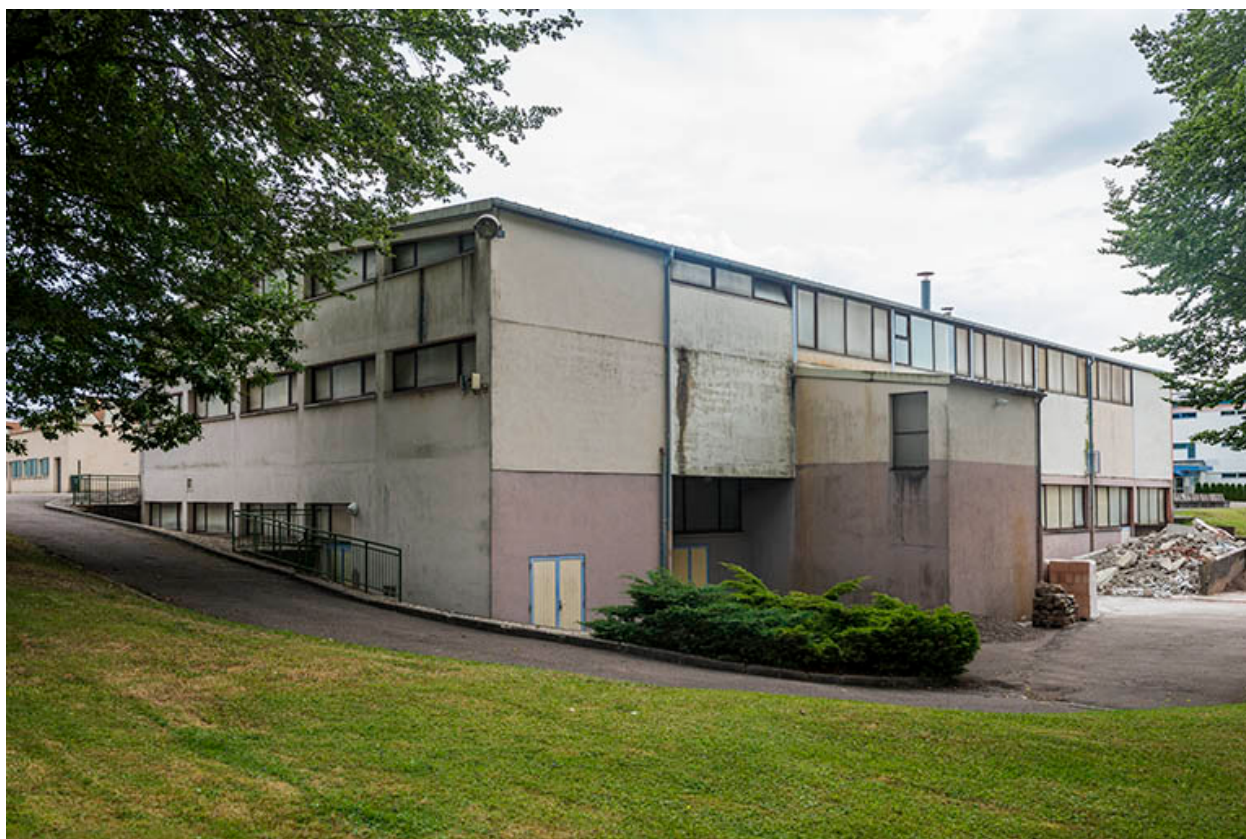
Atelier de gros-oeuvre : façade postérieure.
