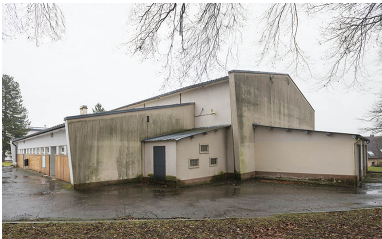
Angle nord-ouest du gymnase.
