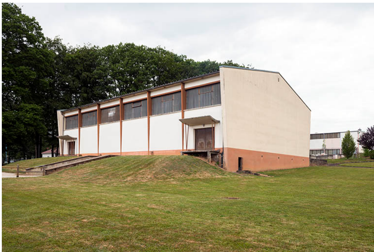
Gymnase : vue postérieure.
