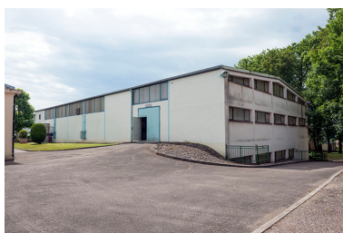
Atelier de gros-oeuvre : façade antérieure. Phot. Mary Ruffinoni IVR43_20147000131NUC4A
