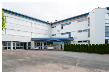
Entrée du lycée : externat. Phot. Mary Ruffinoni IVR43_20147000144NUC4A
