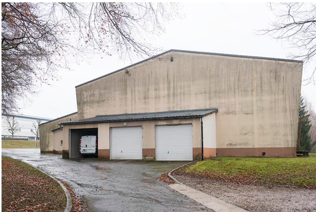
Façade postérieure - ouest - du gymnase.
