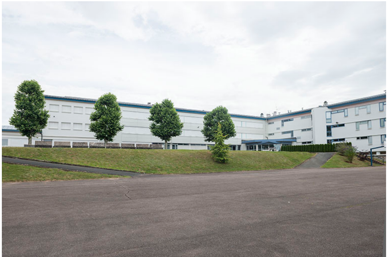
Externat et atelier : façades sur cour.
