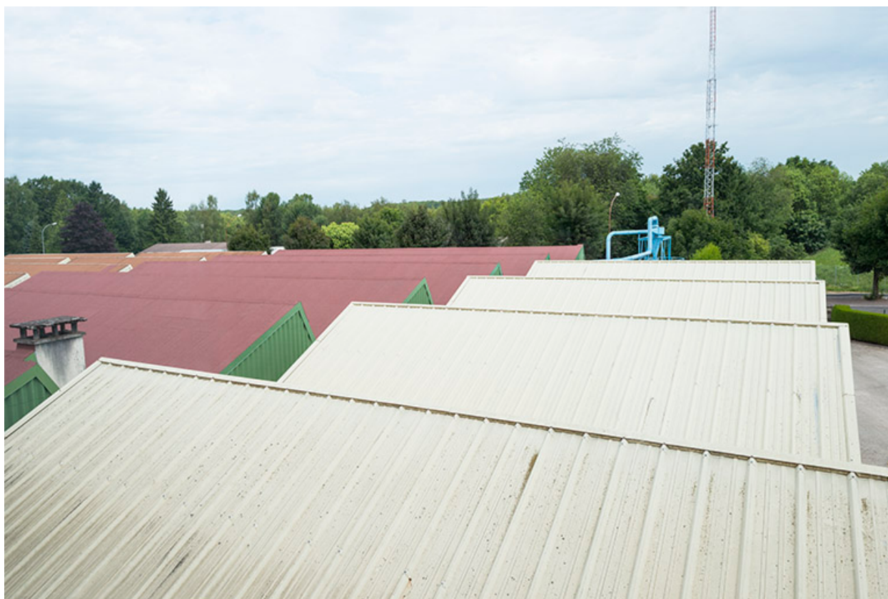
Toitures des ateliers : détail
