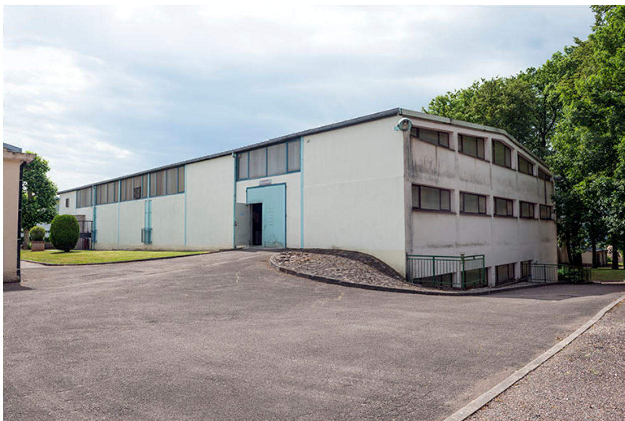
Atelier de gros-oeuvre : façade antérieure.
