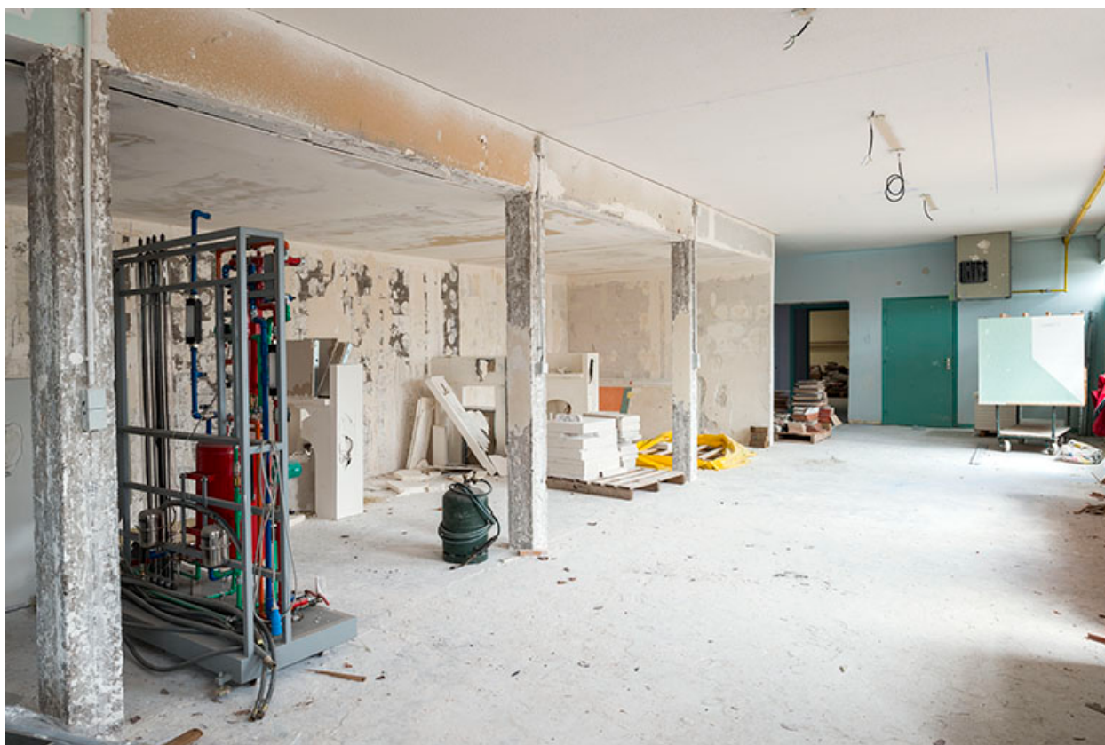
Atelier, bâtiment préfabriqué : plâterie..
