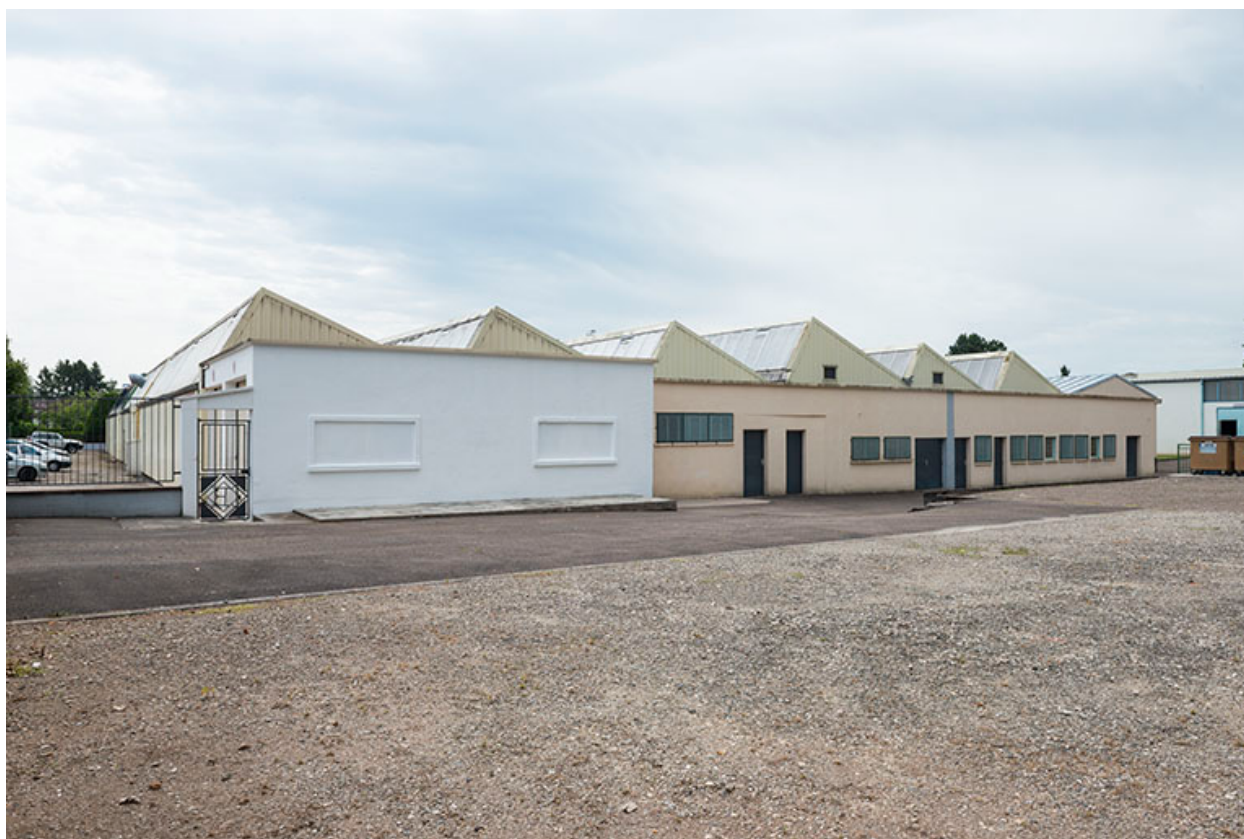
Ateliers : toiture en sheds.
