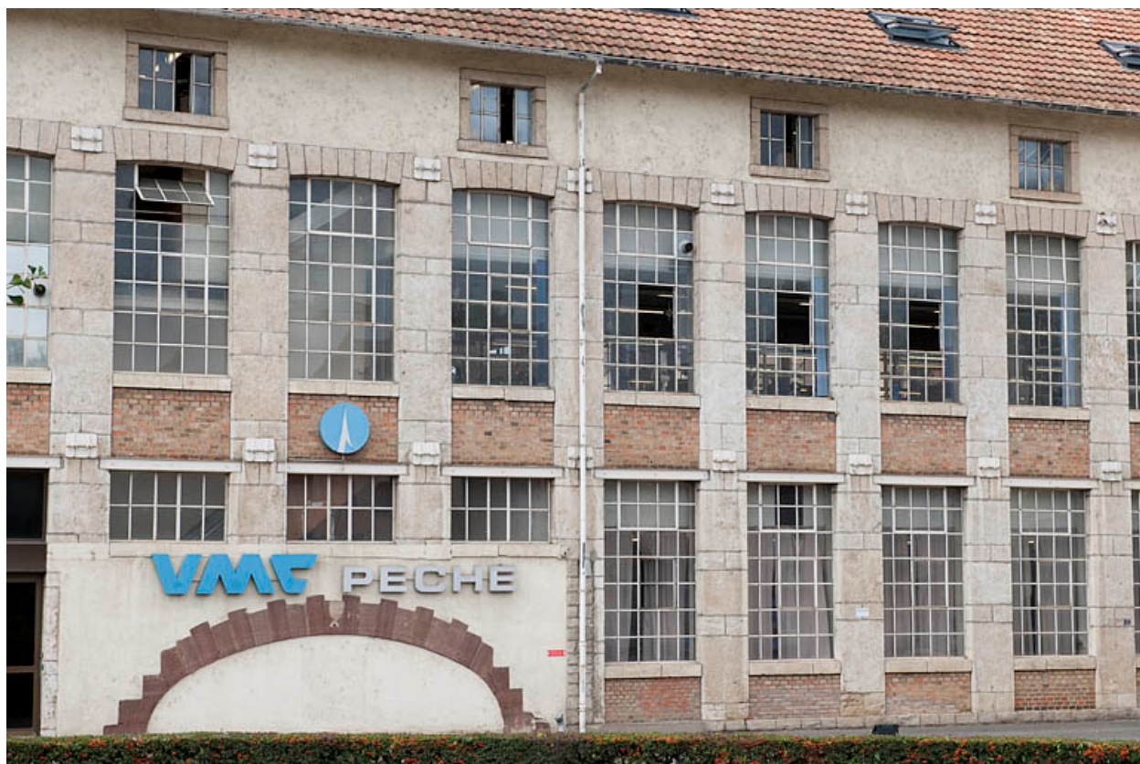
Détail de travées de la façade antérieure.
