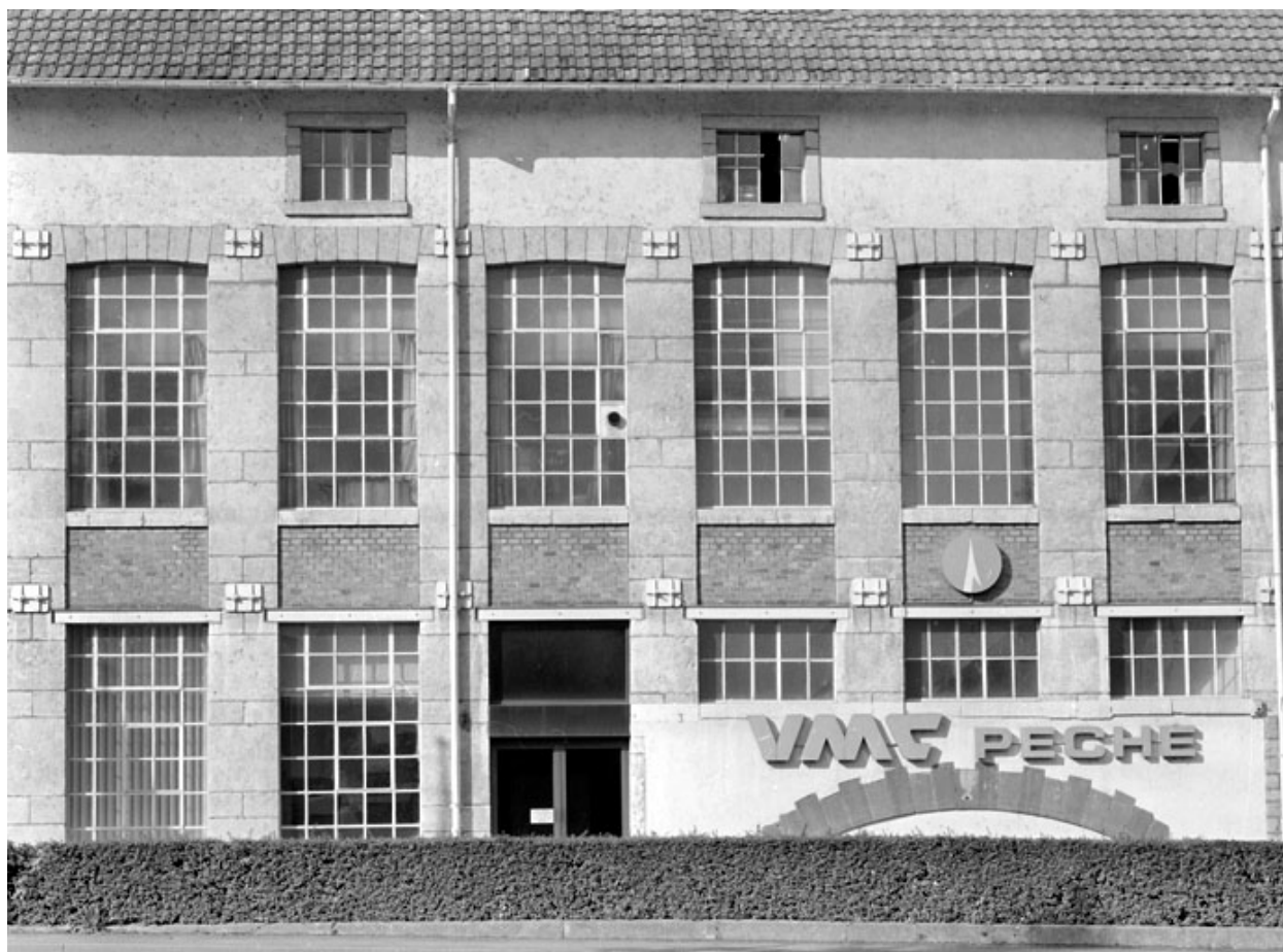
Détail de travées de la façade antérieure.
