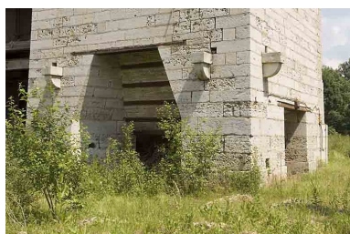
Base de la tour du haut fourneau. Phot. Jérôme Mongreville IVR43_20087000584NUC2A
