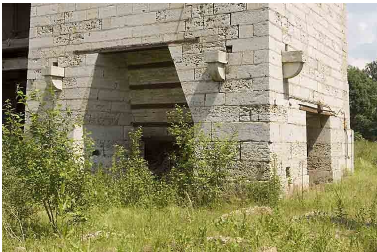
Base de la tour du haut fourneau.
