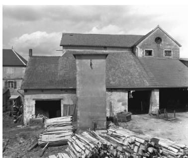
Apprentis dressés contre la façade est du haut fourneau en 1989. Phot. Yves Sancey IVR43_19897000832X
