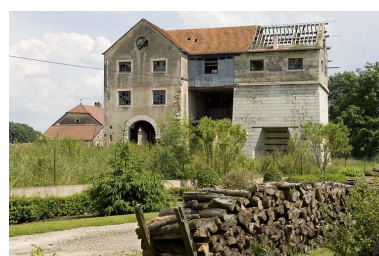
Façade antérieure du haut fourneau. Phot. Jérôme Mongreville IVR43_20087000587NUC2A
