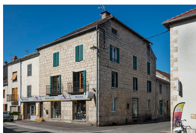
Élévation sur la rue Armand-Paulmard. Phot. Jérôme Mongreville IVR43_20187000438NUC4A
