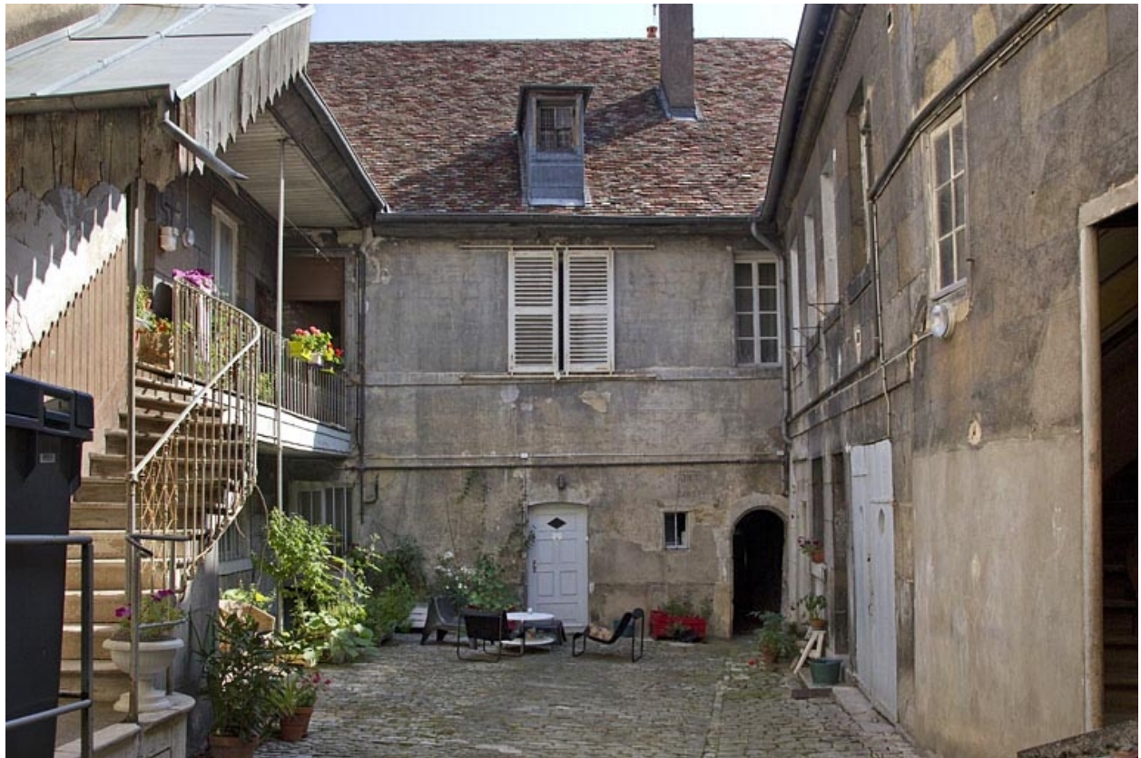
Premier logis secondaire : vue d'ensemble, de face.
