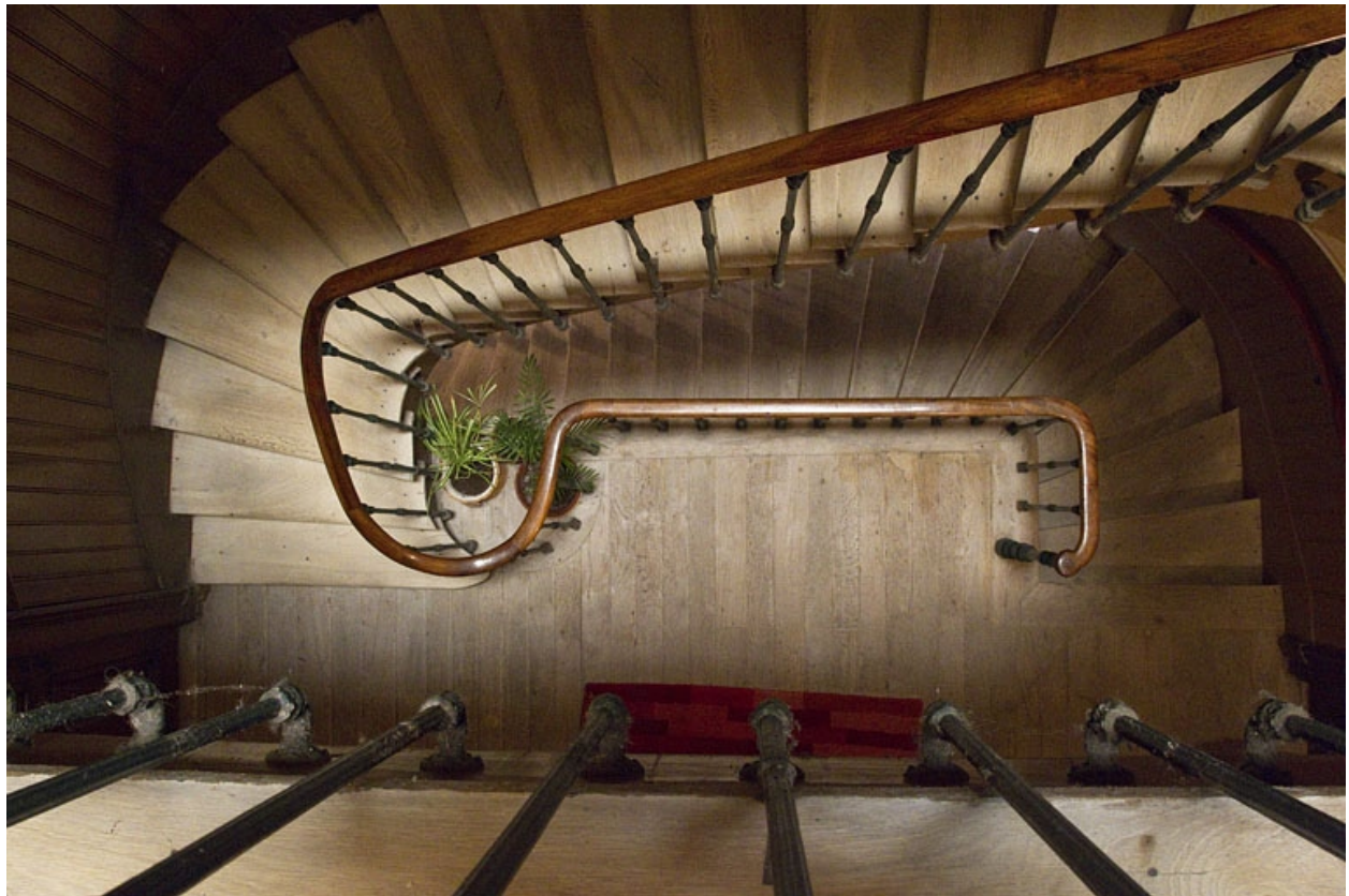
Logis principal : détail de l'escalier, vue plongeante.
