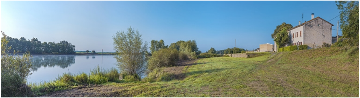
Le port de Farges : mur de soutènement.
