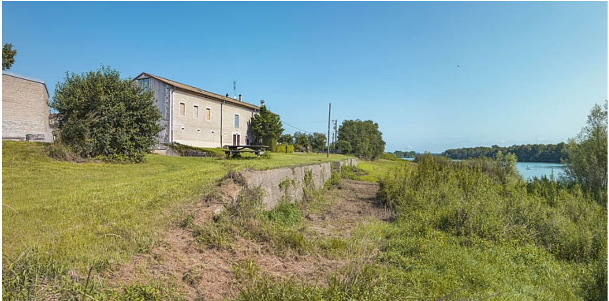
Mur de soutènement du port de Farges.
