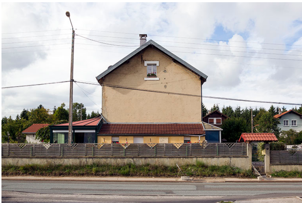
Immeuble au n° 9 : façade latérale sud.
