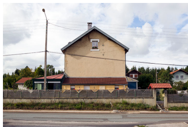
Immeuble au n° 9 : façade latérale sud. Phot. Yves Sancey IVR43_20132501673NUC2A
