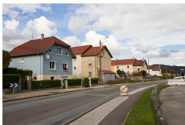
Vue d'ensemble de la cité, depuis l'ouest. Phot. Yves Sancey IVR43_20132501664NUC2A
