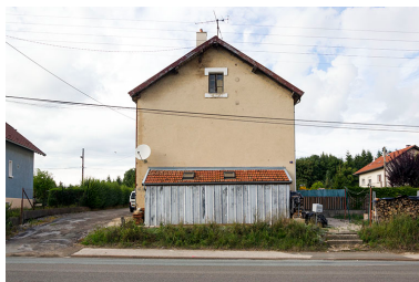
Immeuble au n° 7 : façade latérale sud. Phot. Yves Sancey IVR43_20132501668NUC2A
