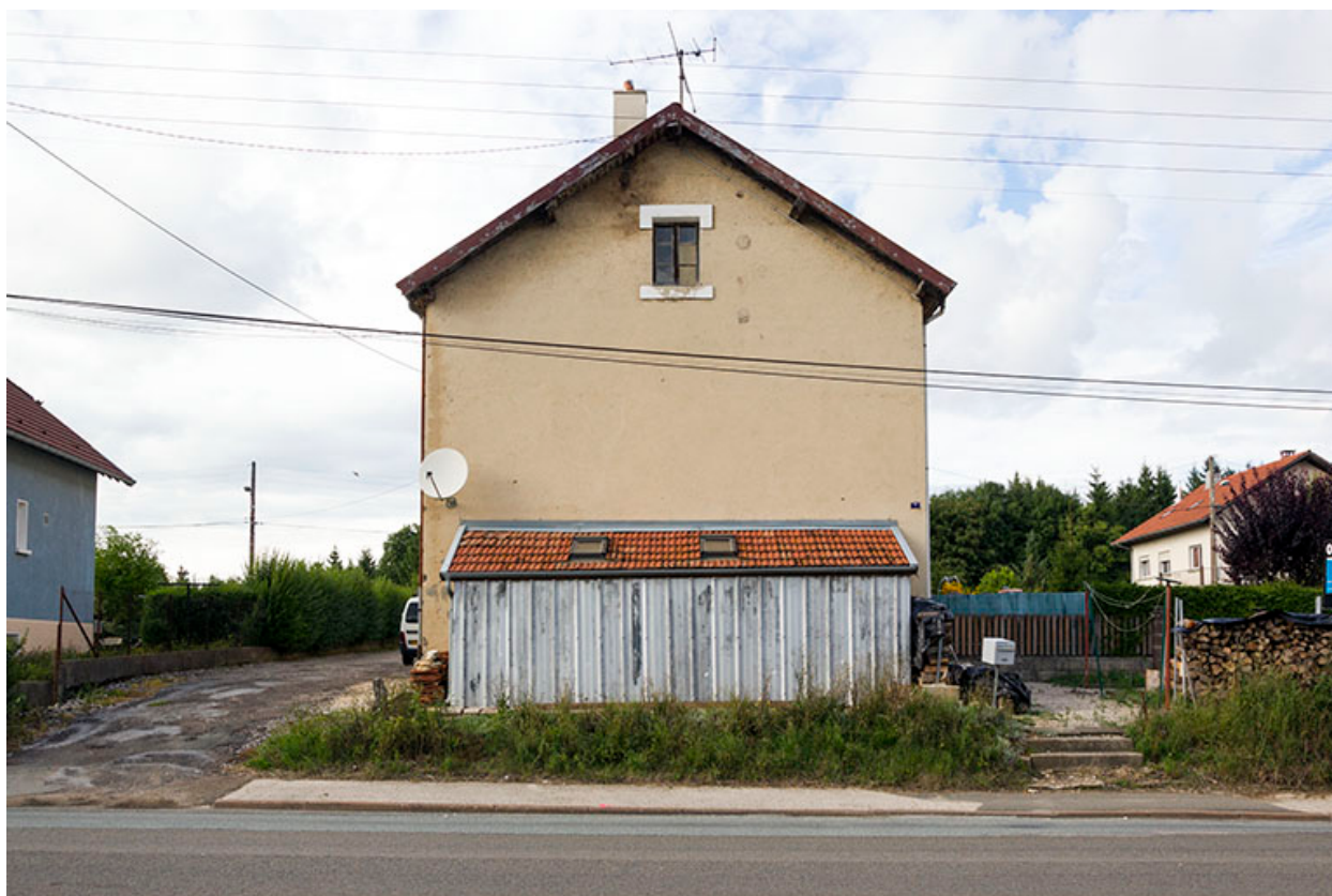
Immeuble au n° 7 : façade latérale sud.
