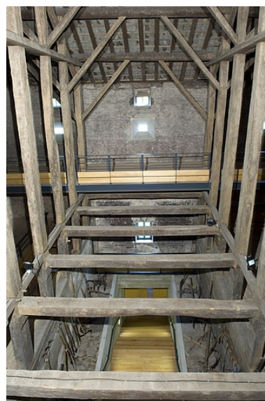
Charpente du fenil. travée centrale. Phot. Jérôme Mongreville IVR43_20067000788NUCA
