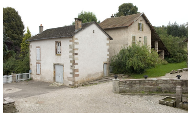
Logement des domestiques. Phot. Jérôme Mongreville IVR43_20077000441NUCA
