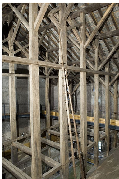
Charpente du fenil (cadrage vertical). Phot. Jérôme Mongreville IVR43_20067000787NUCA
