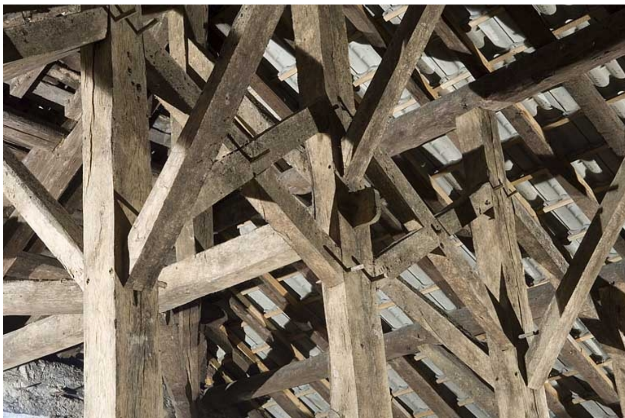
Charpente du fenil. Détail de partie haute.
