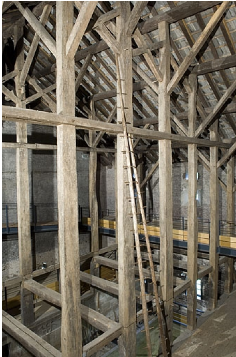
Charpente du fenil (cadrage vertical).
