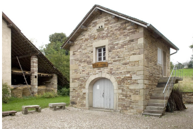
Four à pain. Vue de trois quarts. Phot. Jérôme Mongreville IVR43_20077000442NUCA
