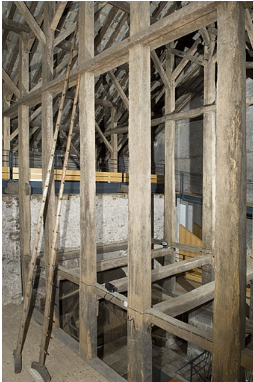
Charpente du fenil. Vue plongeante.
