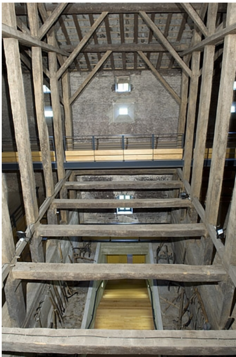
Charpente du fenil. travée centrale.
