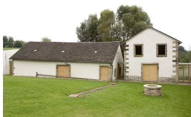
Entrepôt industriel et salle de distillation. Phot. Jérôme Mongreville IVR43_20077000434NUCA
