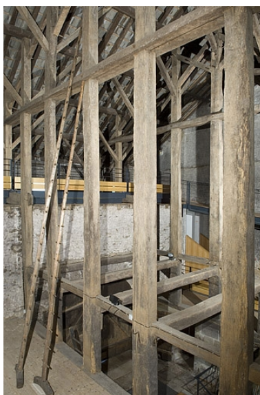
Charpente du fenil. Vue plongeante. Phot. Jérôme Mongreville IVR43_20067000791NUCA
