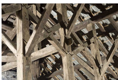
Charpente du fenil. Détail de partie haute. Phot. Jérôme Mongreville IVR43_20067000789NUCA
