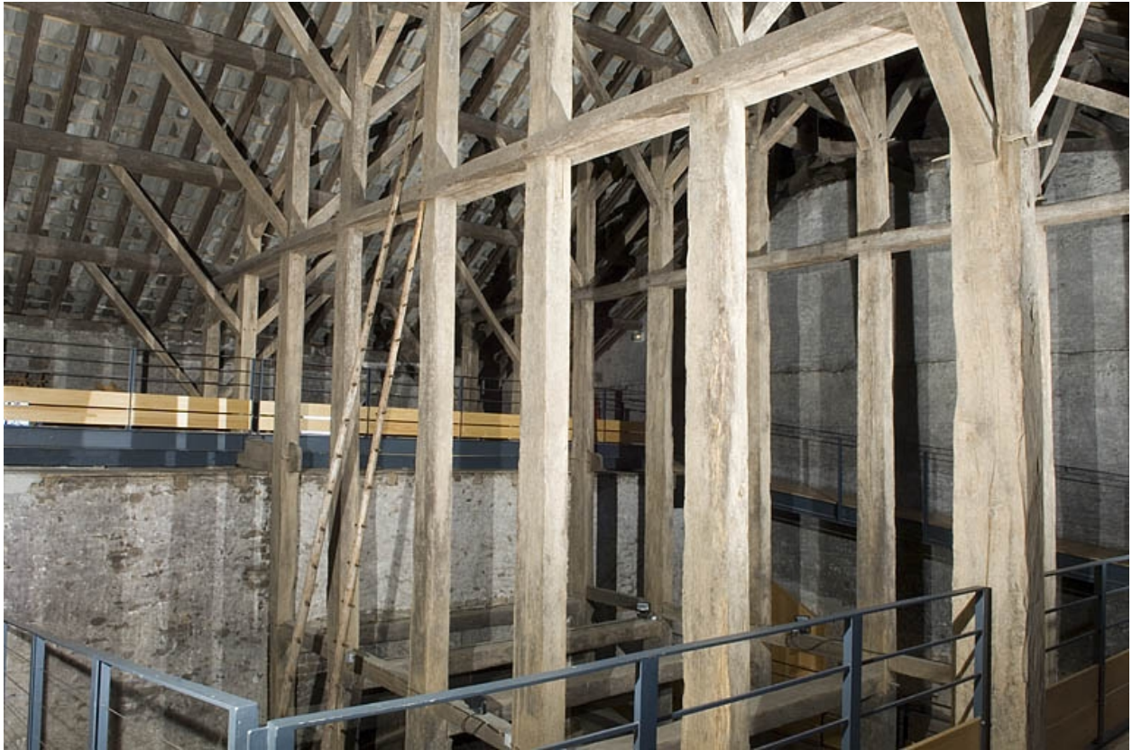
Charpente du fenil (cadrage vertical).
