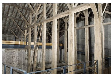
Charpente du fenil (cadrage vertical). Phot. Jérôme Mongreville IVR43_20067000792NUCA
