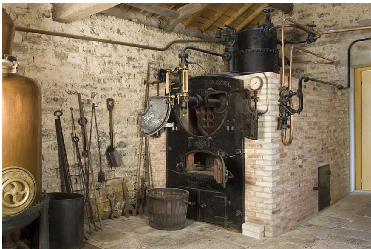
Chaudière Scheidecker et Kohl (Lure), provenant de la distillerie Lemer cier (Prédurupt).
