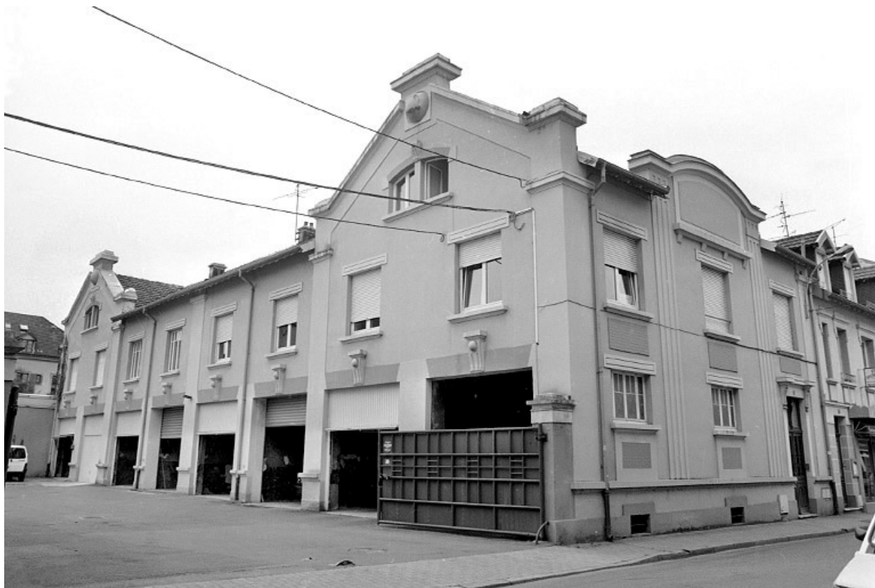
Bâtiment abritant des remises et des logements.
