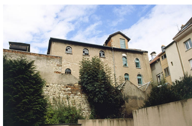
Façade postérieure de l'usine. Phot. Yves Sancey IVR43_20009000657ZA
