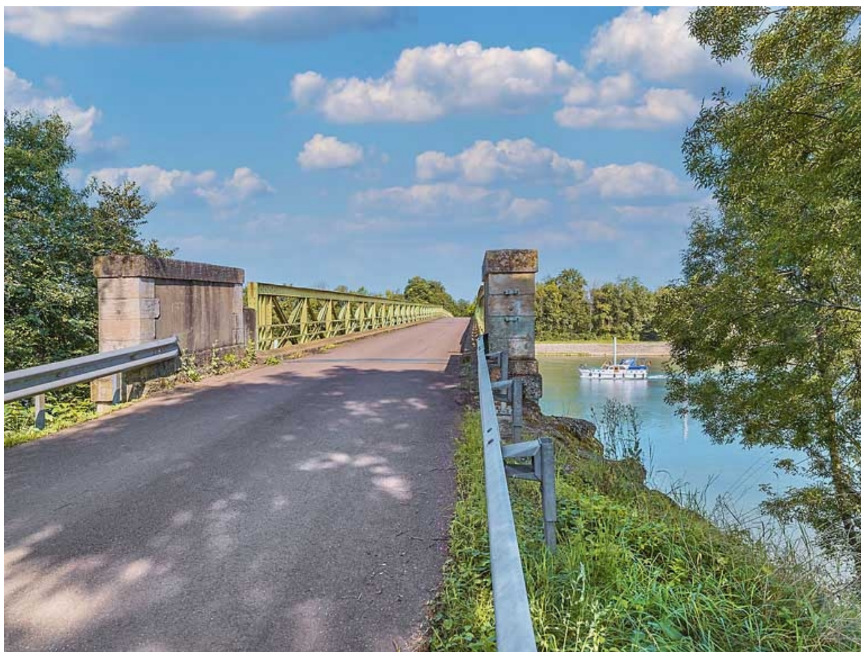
Vue du dessus du pont, rive gauche.
