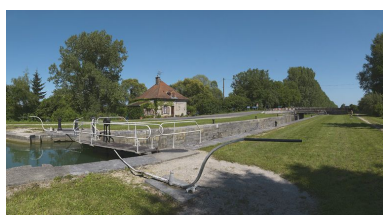
Vue d'amont. Phot. Thierry Kuntz IVR26_20112103124NUC4A
