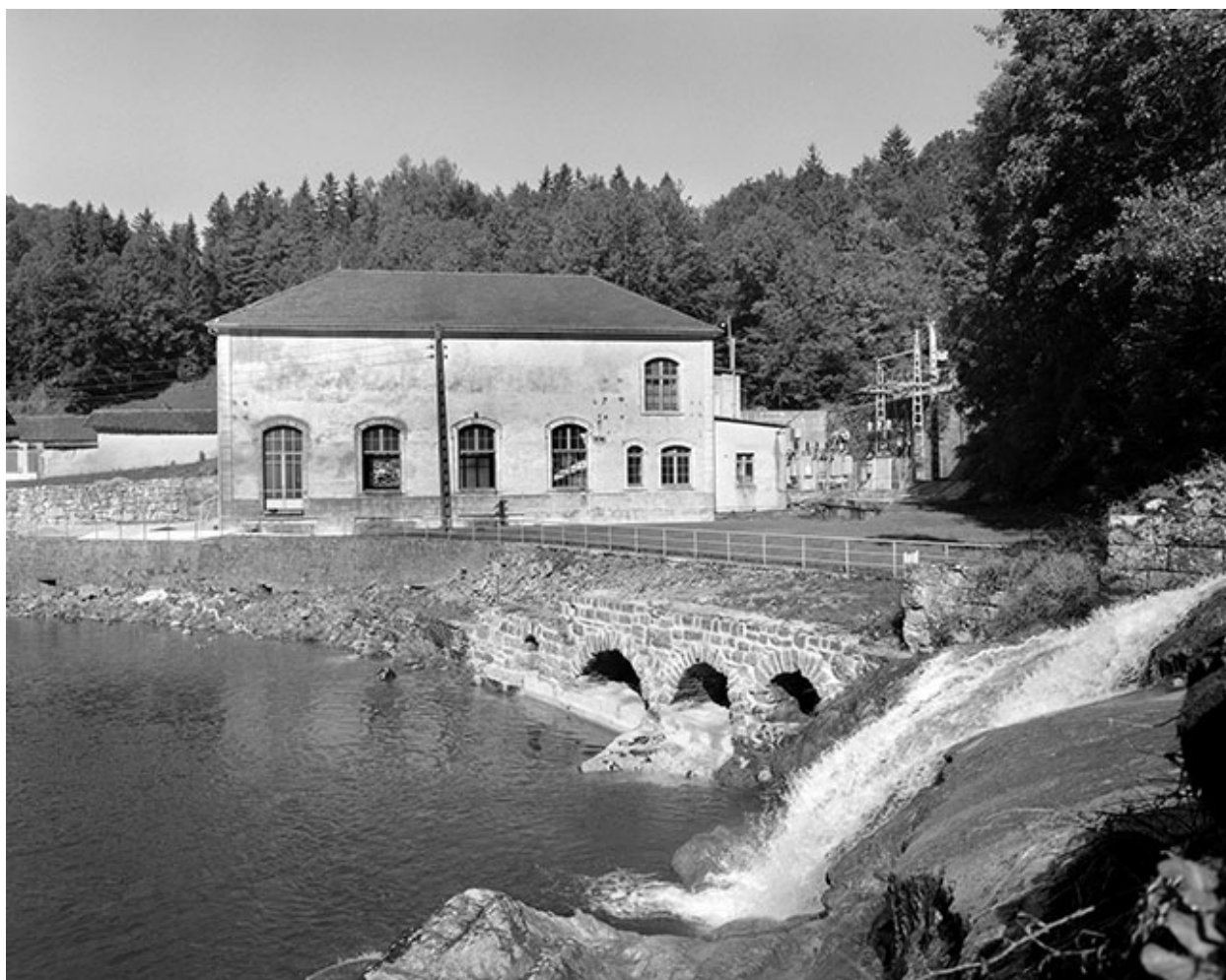
Façade postérieure de la centrale.
