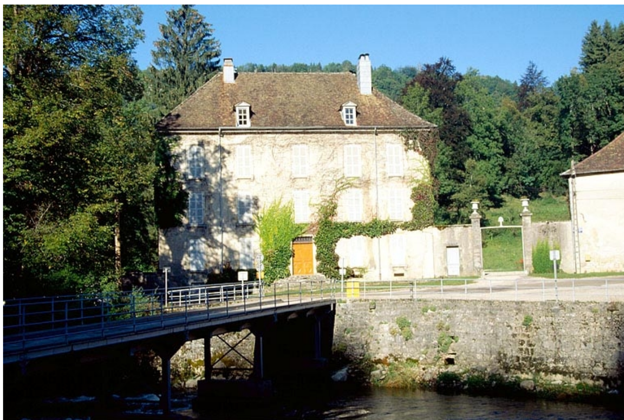
Façade antérieure du logement patronal.
