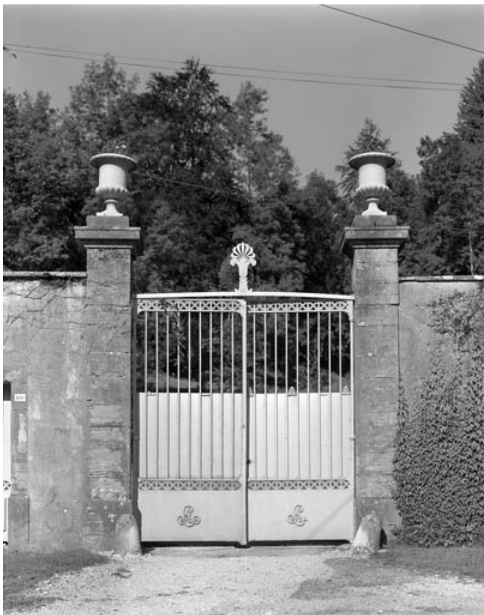
Porte d'entrée du parc.
