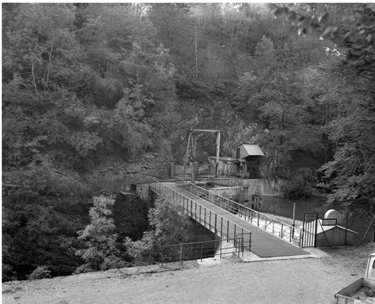
Vue d'ensemble de la prise d'eau.
