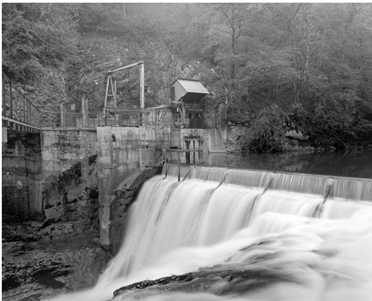
Prise d'eau et barrage.
