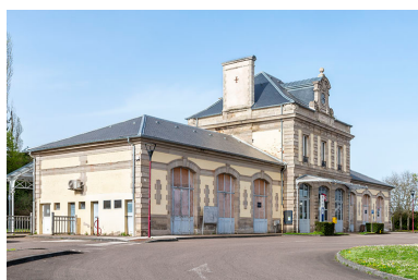
Façade, vue de trois quarts. Phot. Jérôme Mongreville IVR43_20227000144NUC4A
