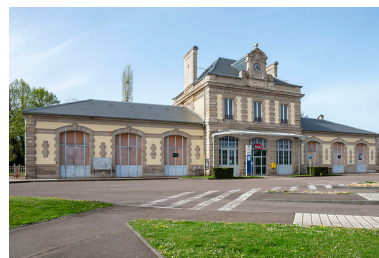
Façade, vue de trois quarts. Phot. Jérôme Mongreville IVR43_20227000145NUC4A
