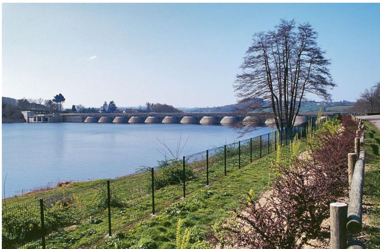
Le barrage, vue d'ensemble d'amont.
