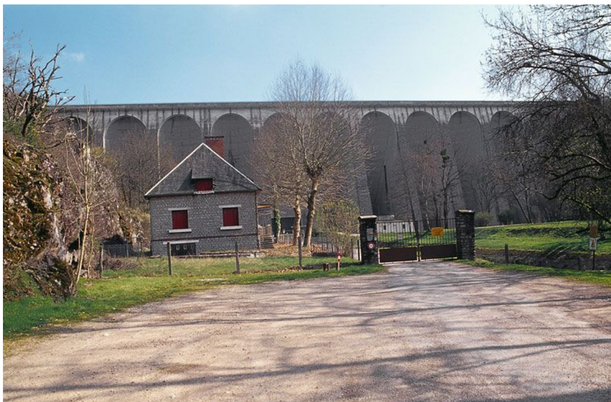
Vue aval du barrage.
