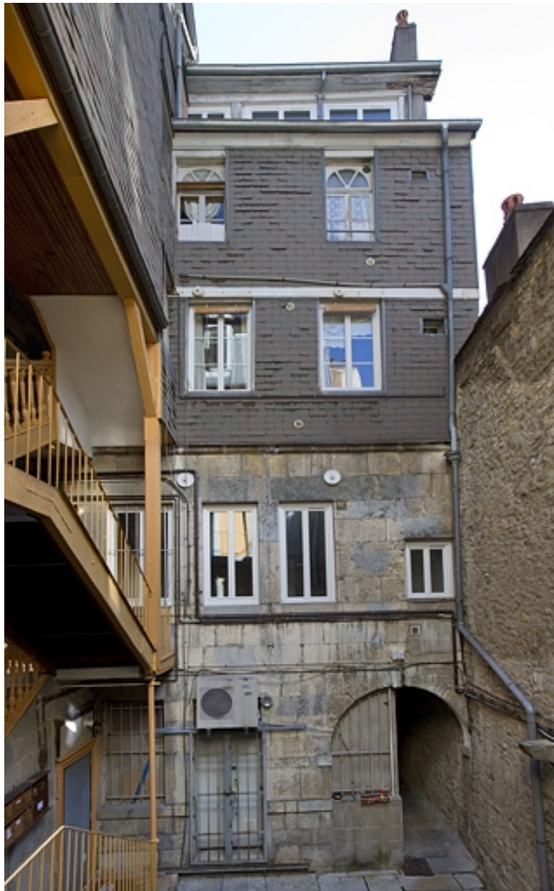
Logis principal, façade postérieure : de face.
