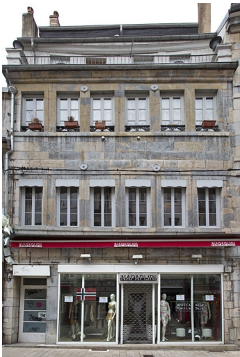
Logis principal, façade antérieure : de face.
