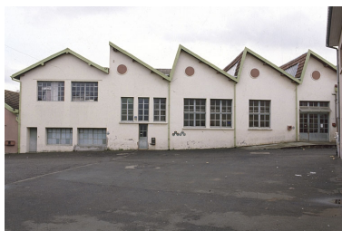
Pignons nord de l'ancien atelier de fabrication.
