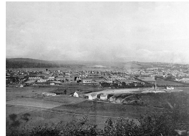
Vue générale de l'usine de Belfort. Phot. Jérôme Mongreville, Austr. Ernest (photographe) Mésière IVR43_20019000223X
