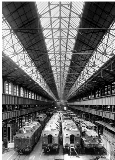
Hall de montage des locomotives diesel-électriques. Phot. Jérôme Mongreville IVR43_20019000172X
