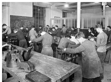
Centre d'apprentissage : atelier d'usinage.
