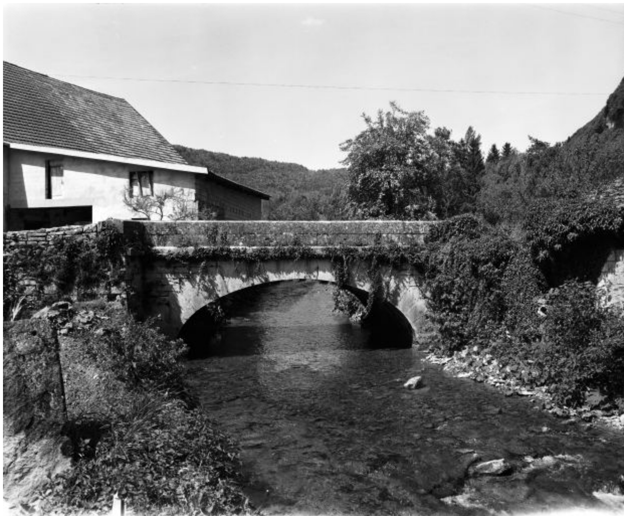
Pont situé sur la route de La Marre.
