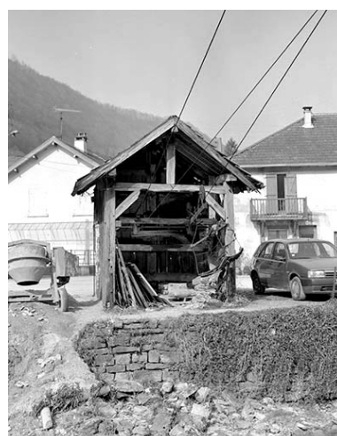
1996. Vue d'ensemble du transporteur automatique par câbles. Le local abrite un treuil permettant
