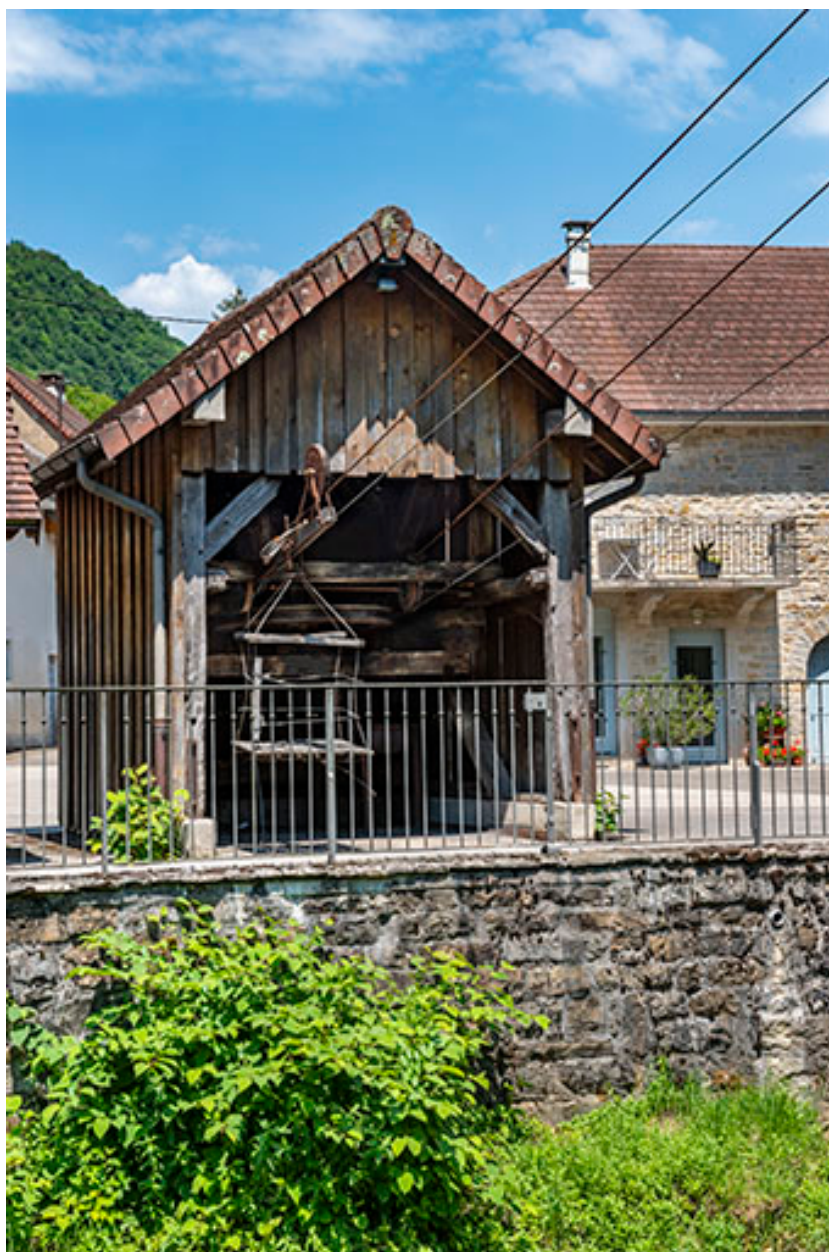
2020. Vue rapprochée du transporteur automatique par câbles.
