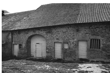
Ferme située route de Nevy. Phot. F. Pernin IVR43_19743900091Z
