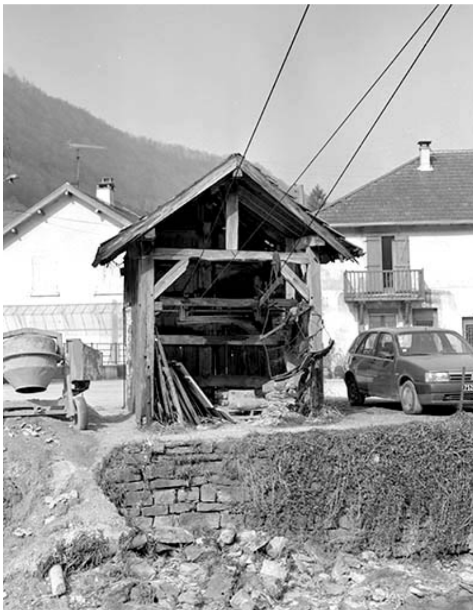
1996. Vue d'ensemble du transporteur automatique par câbles. Le local abrite un treuil permettant d'acheminer le lait, collecté sur le plateau, à la fromagerie du village.
