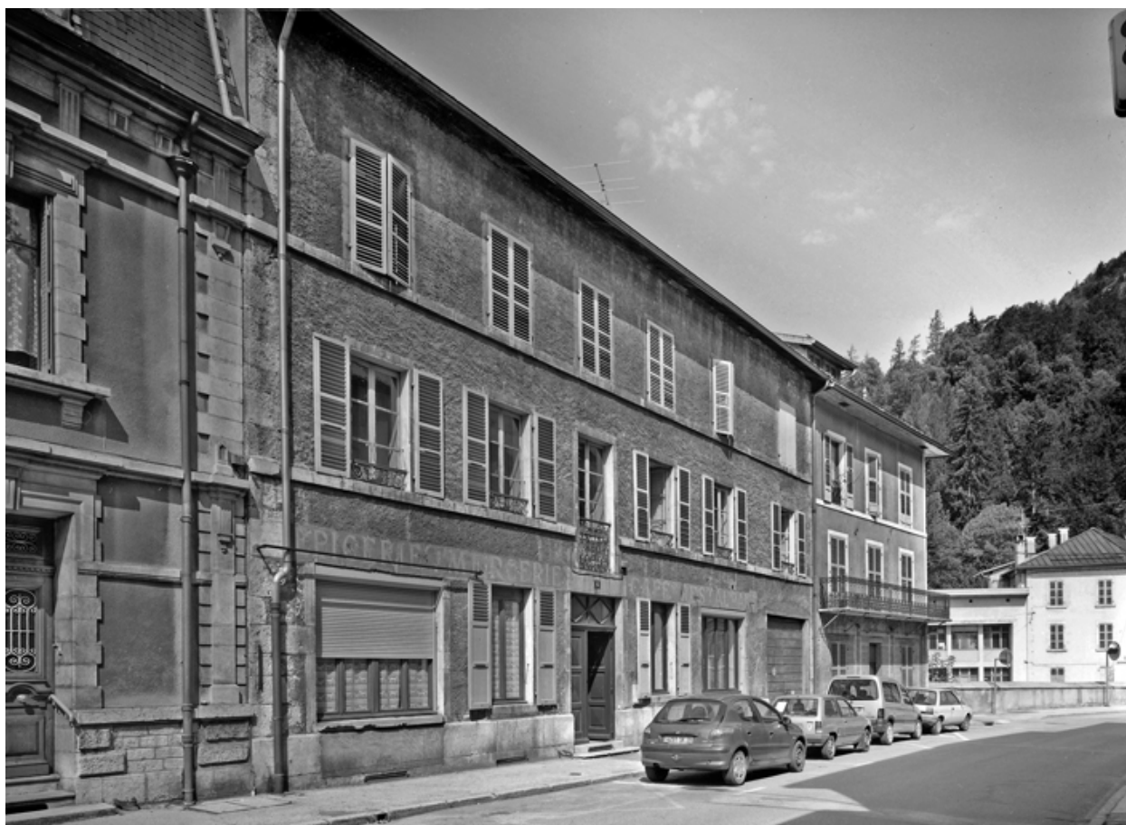
Elévation antérieure, de trois quarts gauche.
