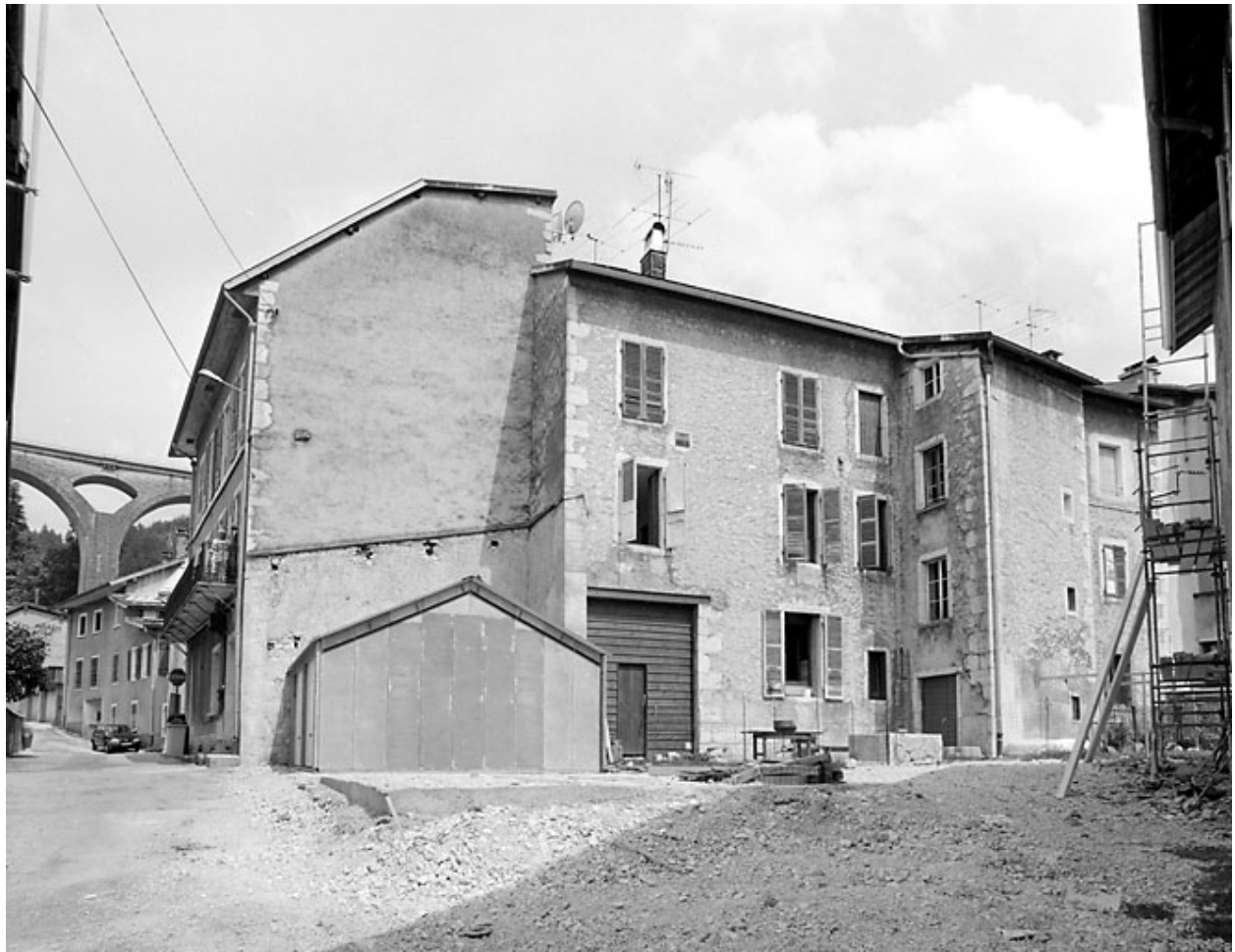
Elévation postérieure, de trois quarts gauche.
