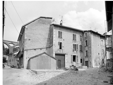
Elévation postérieure, de trois quarts gauche. Phot. Yves Sancey IVR43_20033900125X
