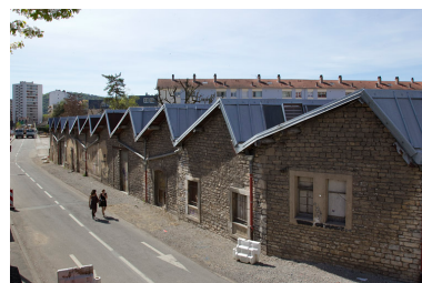
Ancienne usine Amstoutz-Ravel puis de la Sadim, Besançon (28 avenue Fontaine-Argent). Phot. Yves Sancey IVR43_20112502329NUC2A
