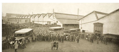
Vue d'ensemble des Ets Doll à Vesoul, [1949]. Phot. Jérôme Mongreville IVR43_20097000085NUC2A
