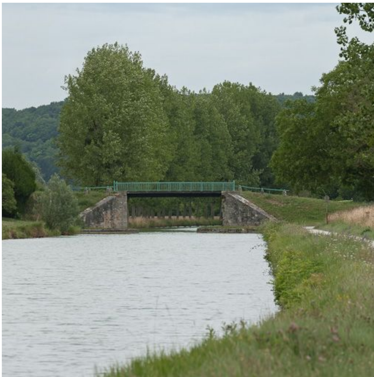
Vue du pont.
