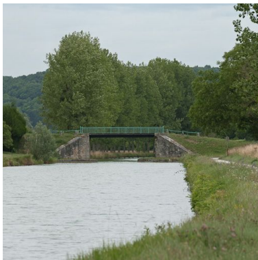
Vue du pont. Phot. Pierre-Marie Barbe-Richaud IVR26_20118900353NUC2AQ
