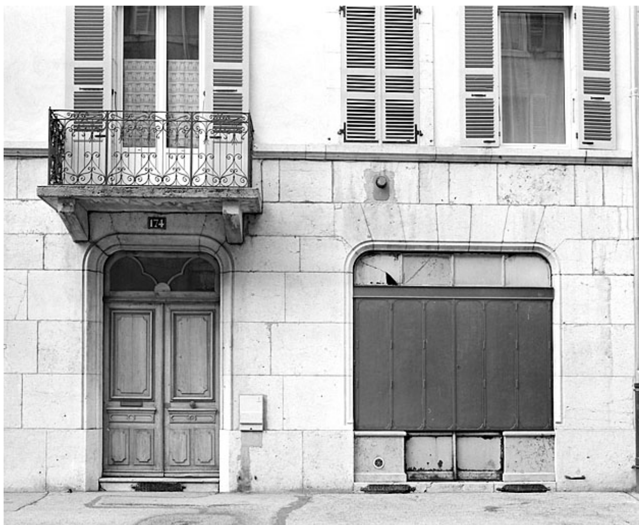
Entrée principale et boutique droite.
