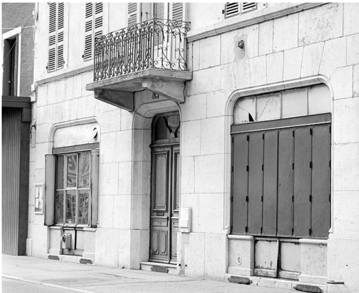
Rez-de-chaussée, de trois quarts droite.
