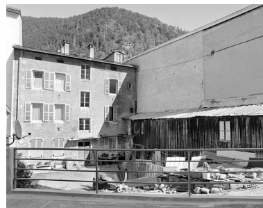
Elévation postérieure. Phot. Yves Sancey IVR43_20033900412X
