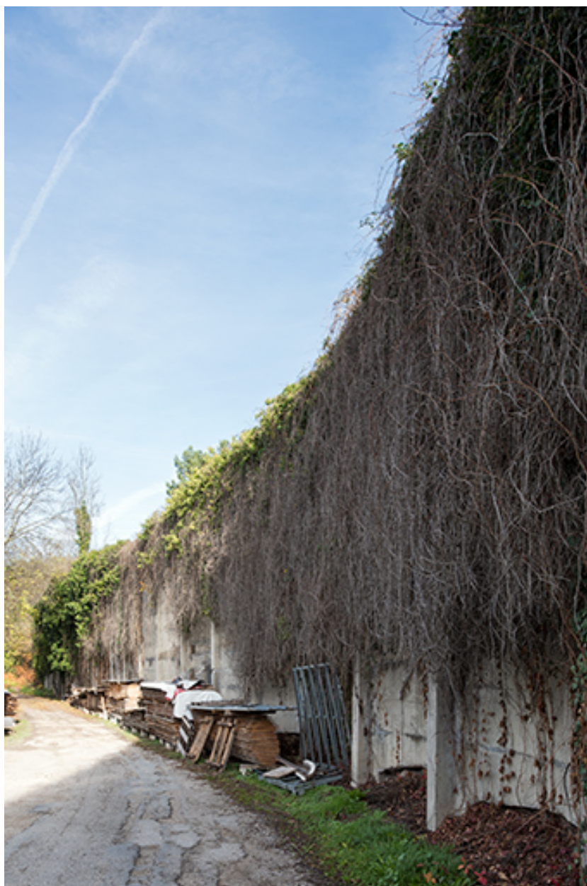
Mur de soutènement, depuis le sud.
