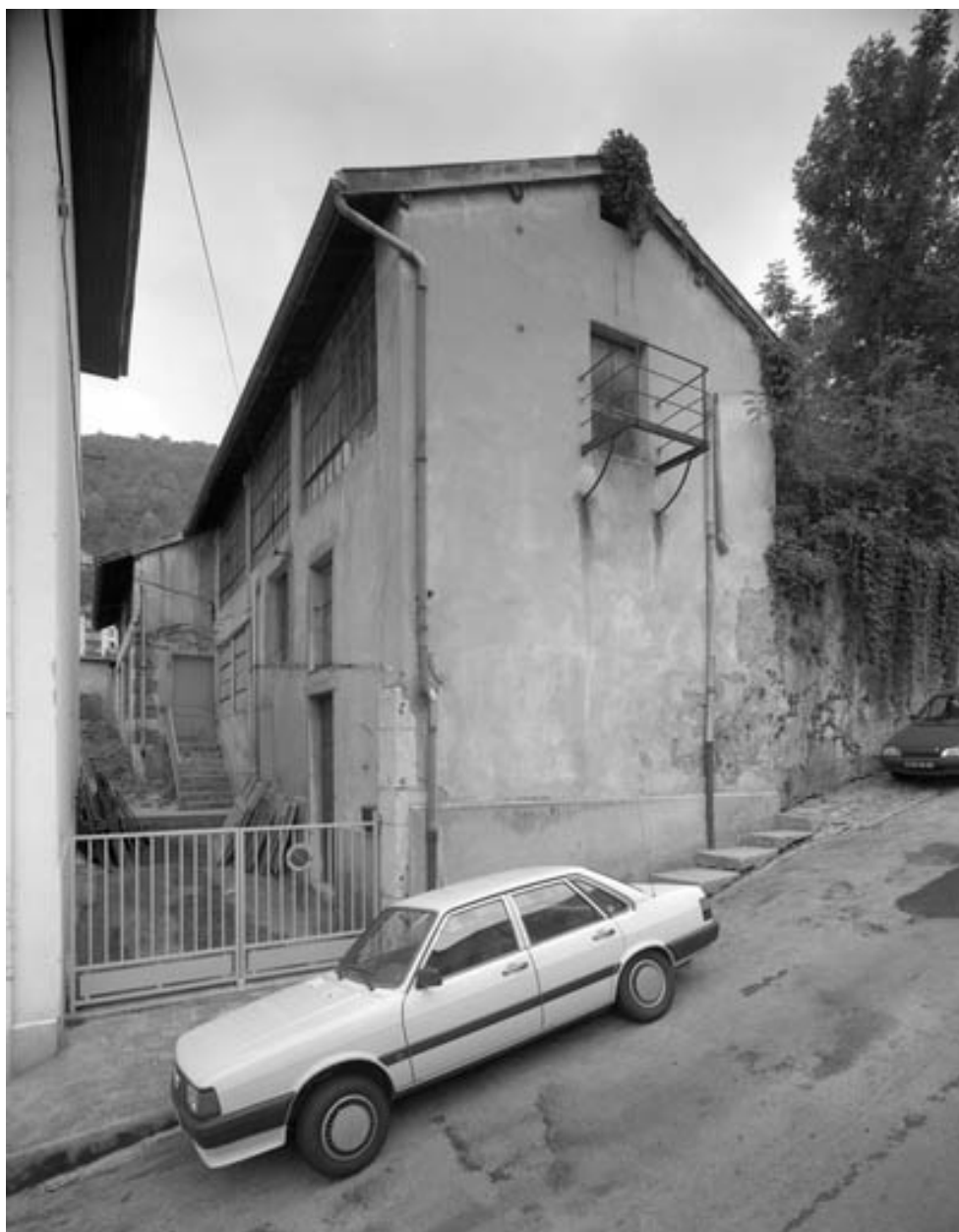
Entrepôts industriels (ancienne usine Genoud).
