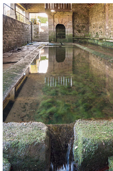
Le bassin et son déversoir. Phot. Jérôme Mongreville IVR43_20167000494NUC4A
