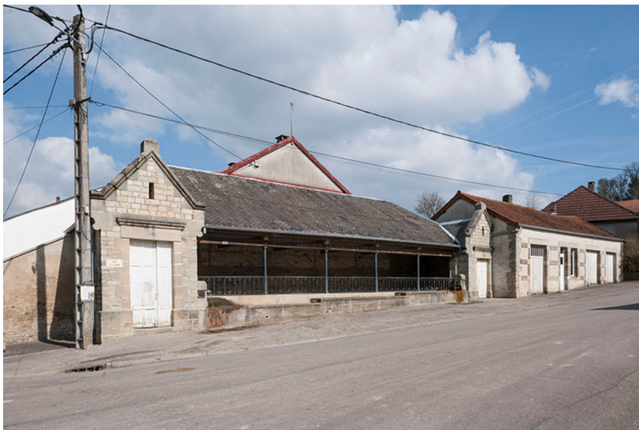
Le lavoir, rue de la Vigne.
