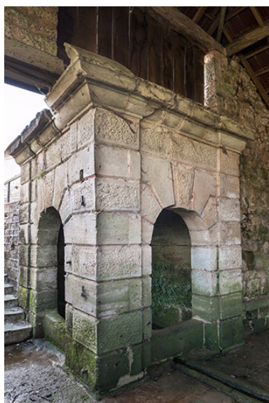
La fontaine alimentant le lavoir. Phot. Jérôme Mongreville IVR43_20167000496NUC4A
