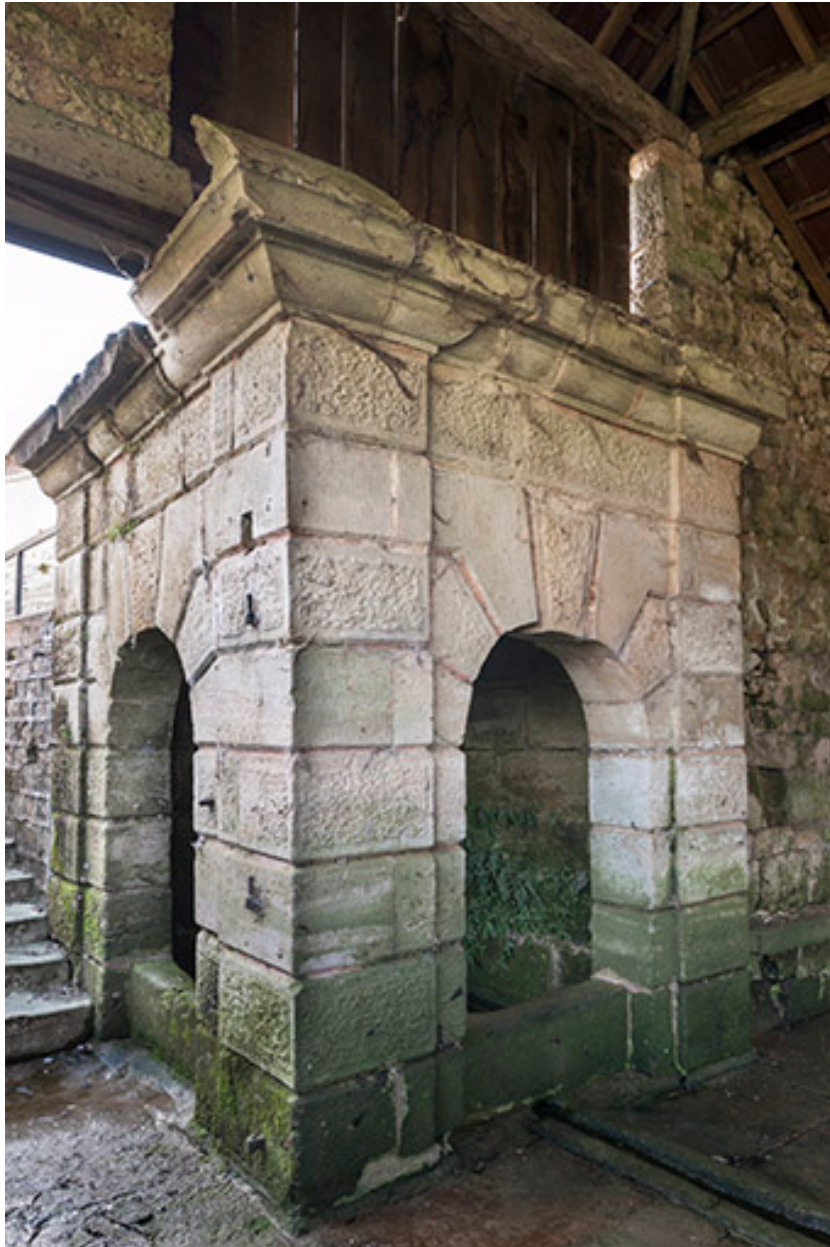
La fontaine alimentant le lavoir.
