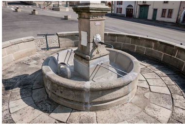
Intérieur de la fontaine. Phot. Jérôme Mongreville IVR43_20167000477NUC4A
