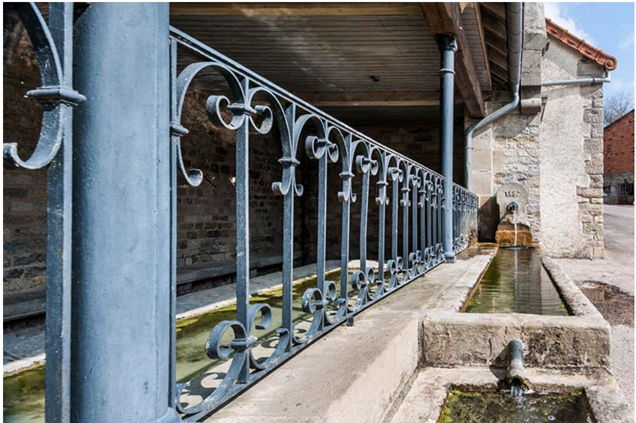
Le garde-corps et les abreuvoirs.
