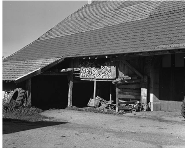
Façade latérale gauche. Phot. Bernard Lardière IVR43_19782500296X
